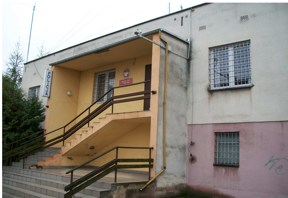
Stan istniejący - widok ogólny - front
