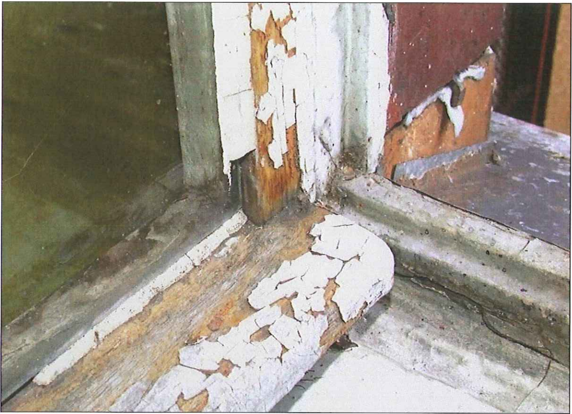
Fot. 49 Okna typu O8, uszkodzenia – boczna klatka schodowa
