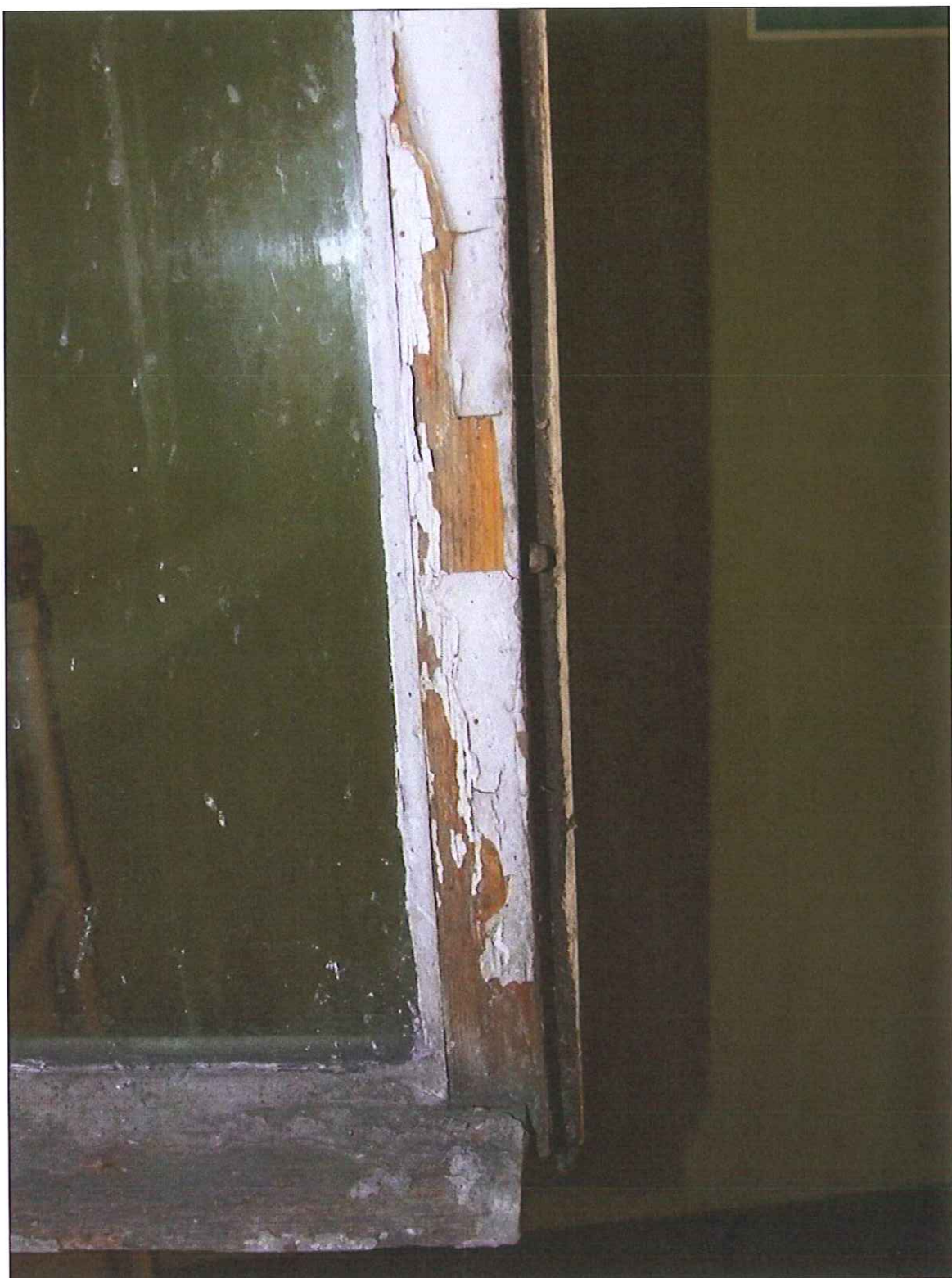
Fot. 43 Okno typu O7, uszkodzenia – boczna klatka schodowa
