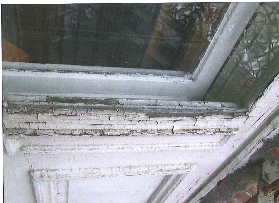
Fot. 19 Drzwi balkonowe typu O1 b, uszkodzenia – elewacja wschodnia
