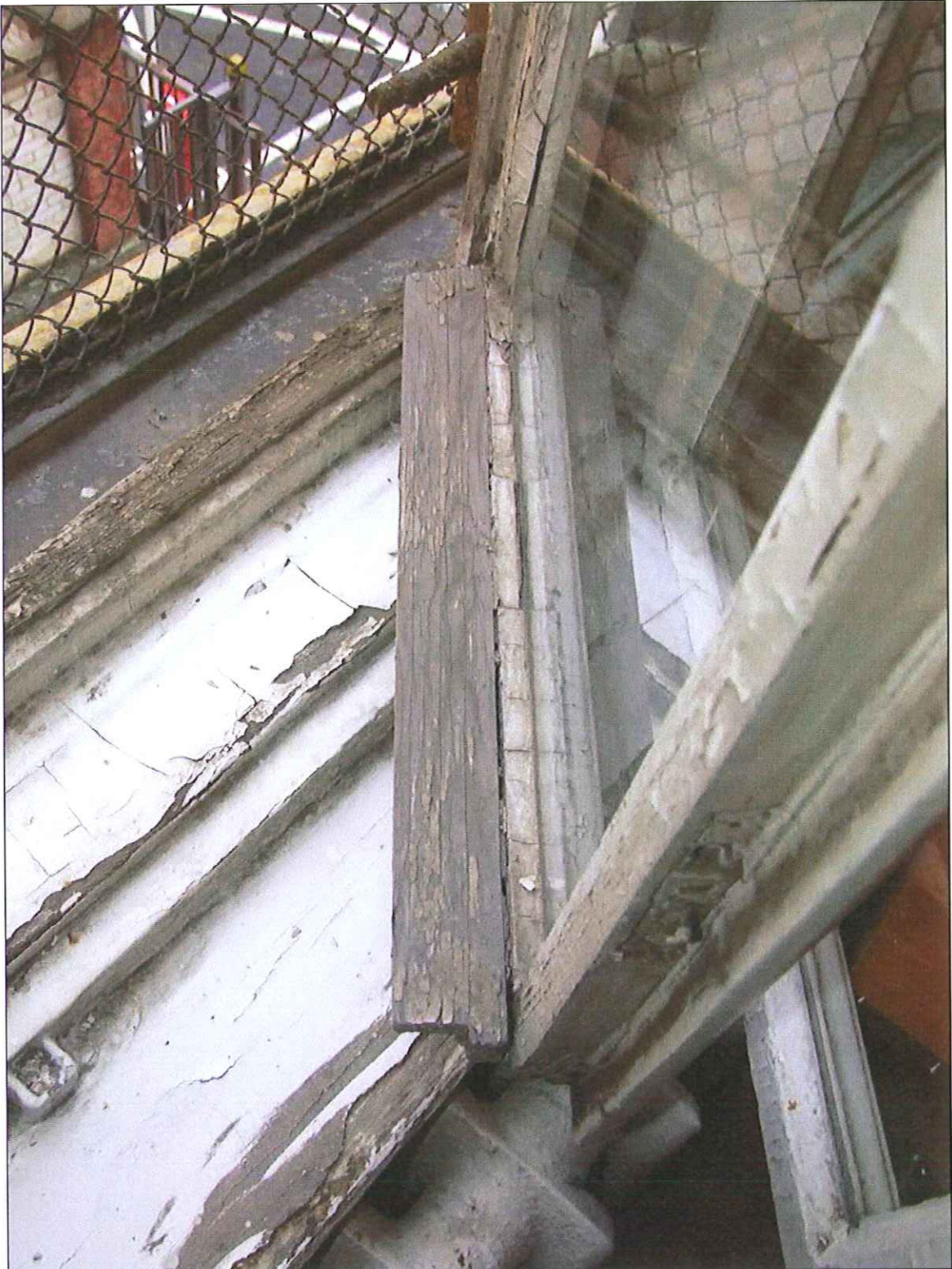
Fot. 14 Okno typu O1 a, uszkodzenia – elewacja południowa
