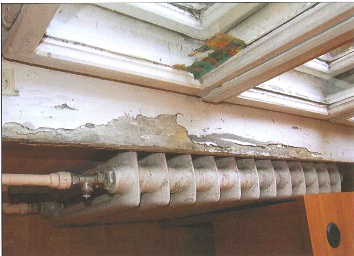
Fot. 15 Okno typu O1 a, uszkodzenia – elewacja południowa
