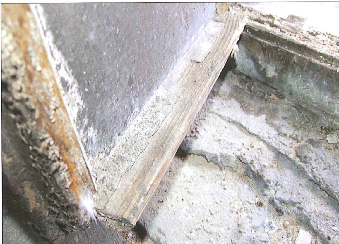
Fot. 31 Okno typu O3, uszkodzenia – poddasze, elewacja południowa
