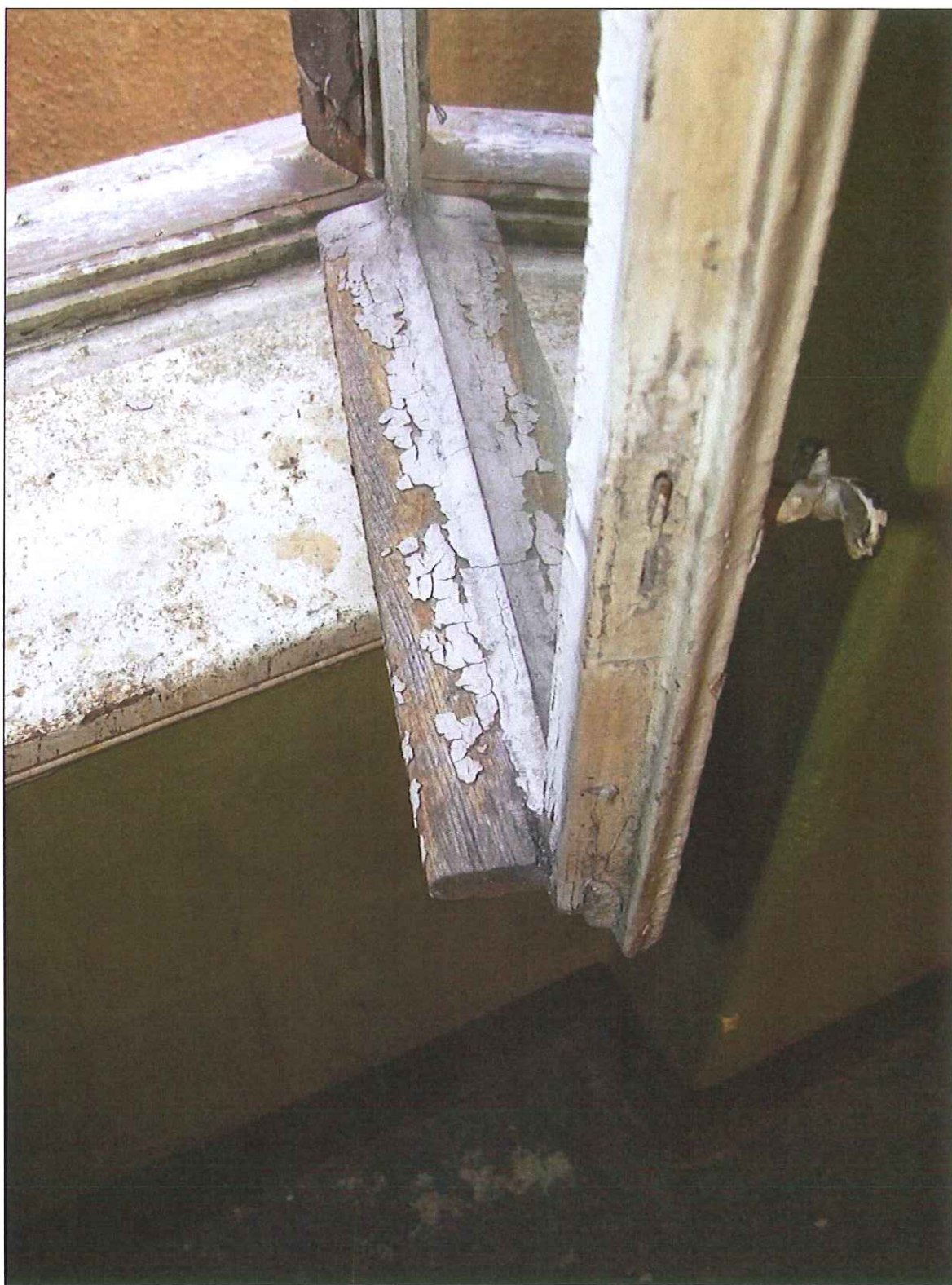
Fot. 48 Okna typu O8, uszkodzenia – boczna klatka schodowa
