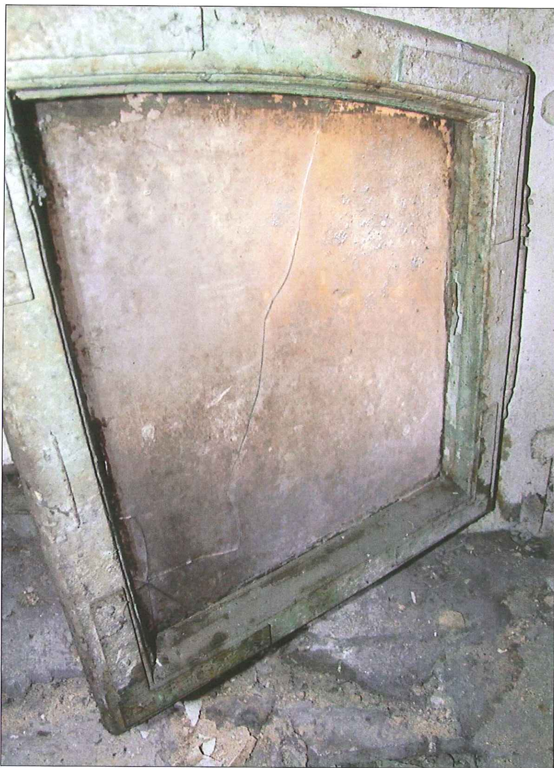
Fot. 32 Okno typu O3, uszkodzenia – poddasze, elewacja południowa
