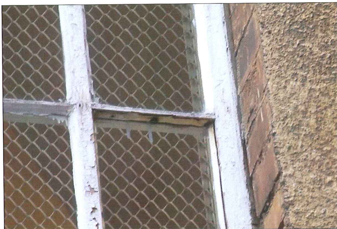
Fot. 27 Okno typu O2, uszkodzenia – elewacja zachodnia
