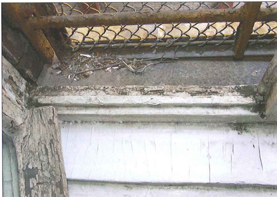
Fot. 16 Okno typu O1 a, uszkodzenia – elewacja południowa
