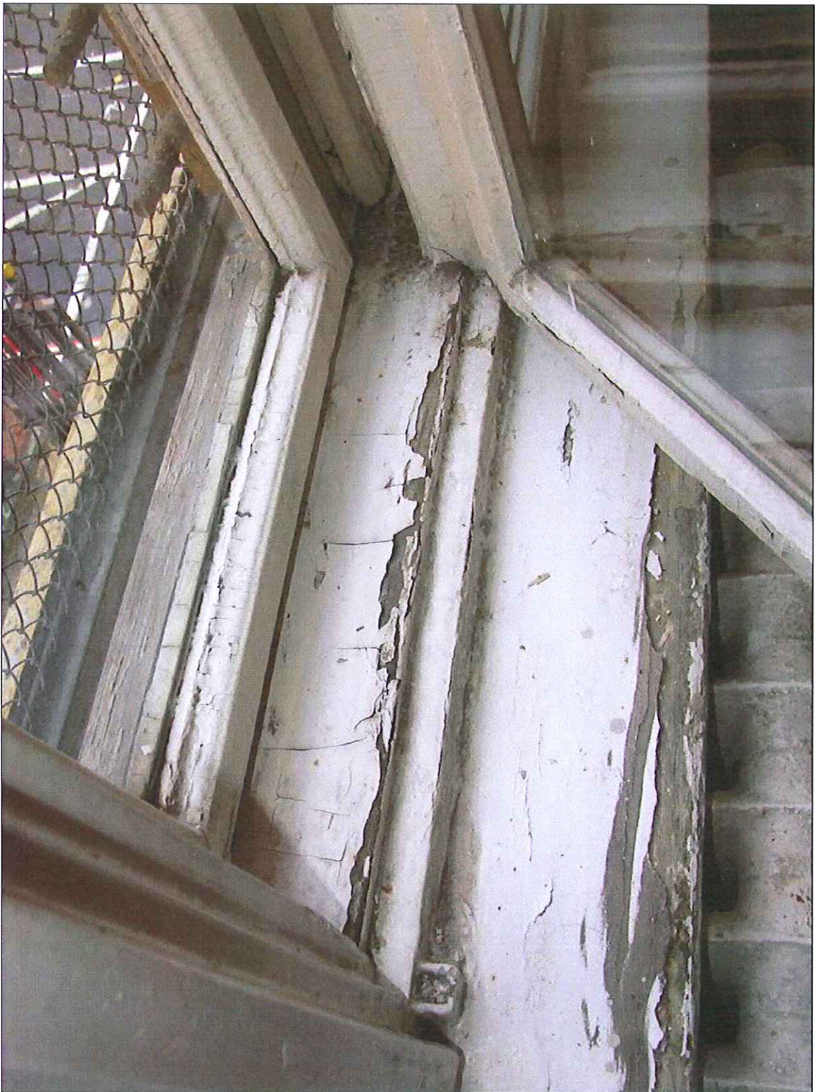
Fot. 13 Okno typu O1 a, uszkodzenia – elewacja południowa
