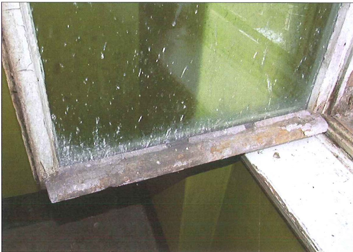
Fot. 42 Okno typu O7, uszkodzenia – boczna klatka schodowa
