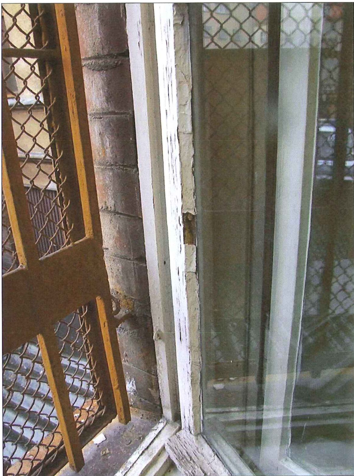
Fot. 11 Okno typu O1 (wariant ze szprosami), uszkodzenia – elewacja zachodnia
