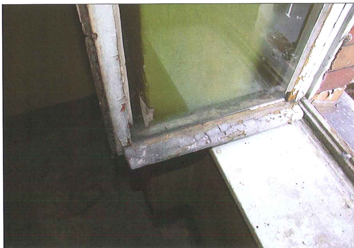
Fot. 47 Okna typu O8, uszkodzenia – boczna klatka schodowa
