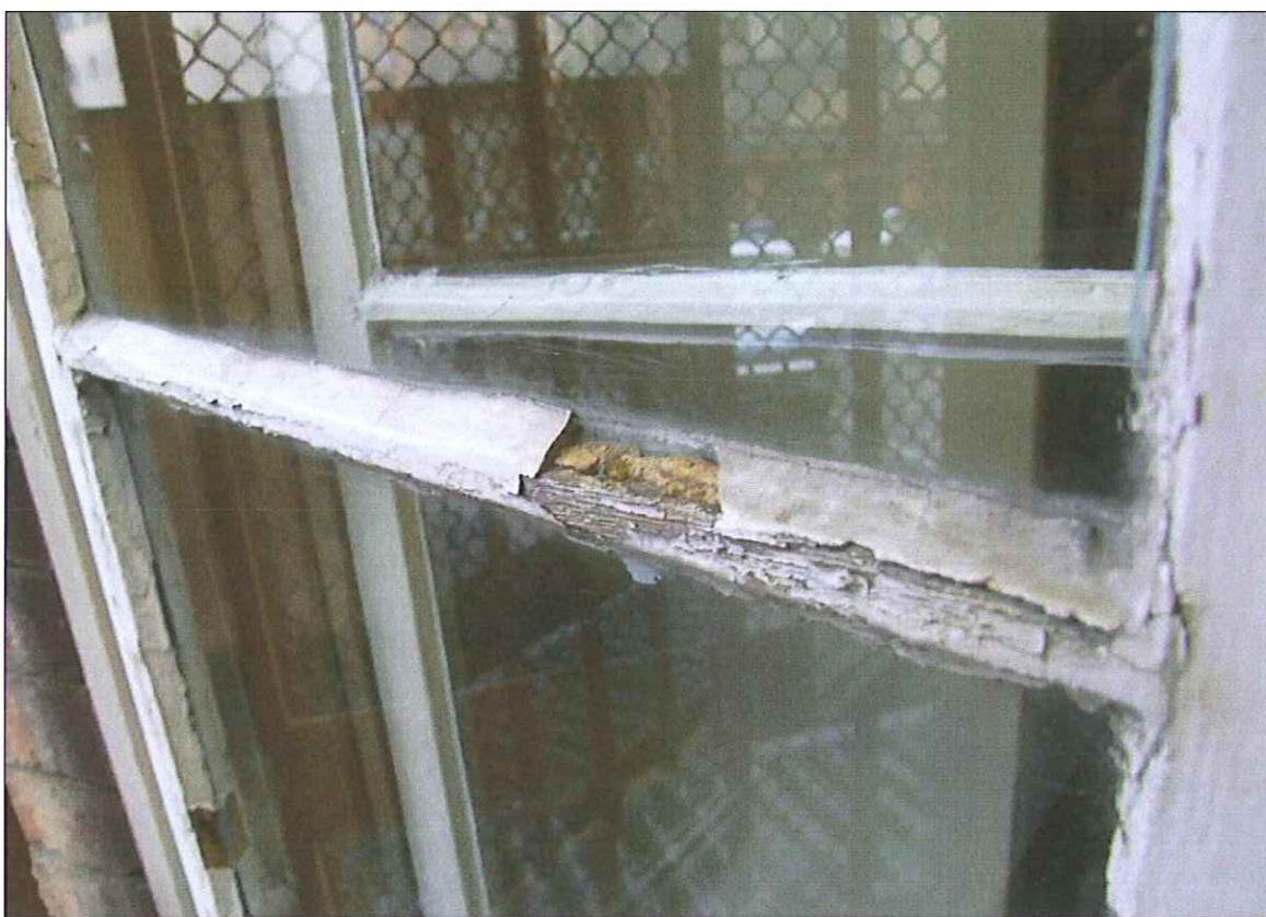
Fot. 9 Okno typu O1 (wariant ze szprosami), uszkodzenia – elewacja zachodnia
