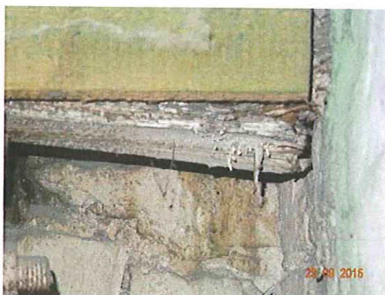
Fot. 14 Zniszczenia korozyjne oczepu tylnej ramy kolankowej w strefie oparcia na ścianie oddzielającej od prawego skrzydła budynku.
