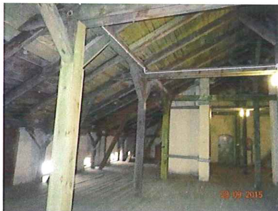
Fot. 4-4 Przykłady elementów więźby osłoniętych, a nie wzmocnionych deskami.
