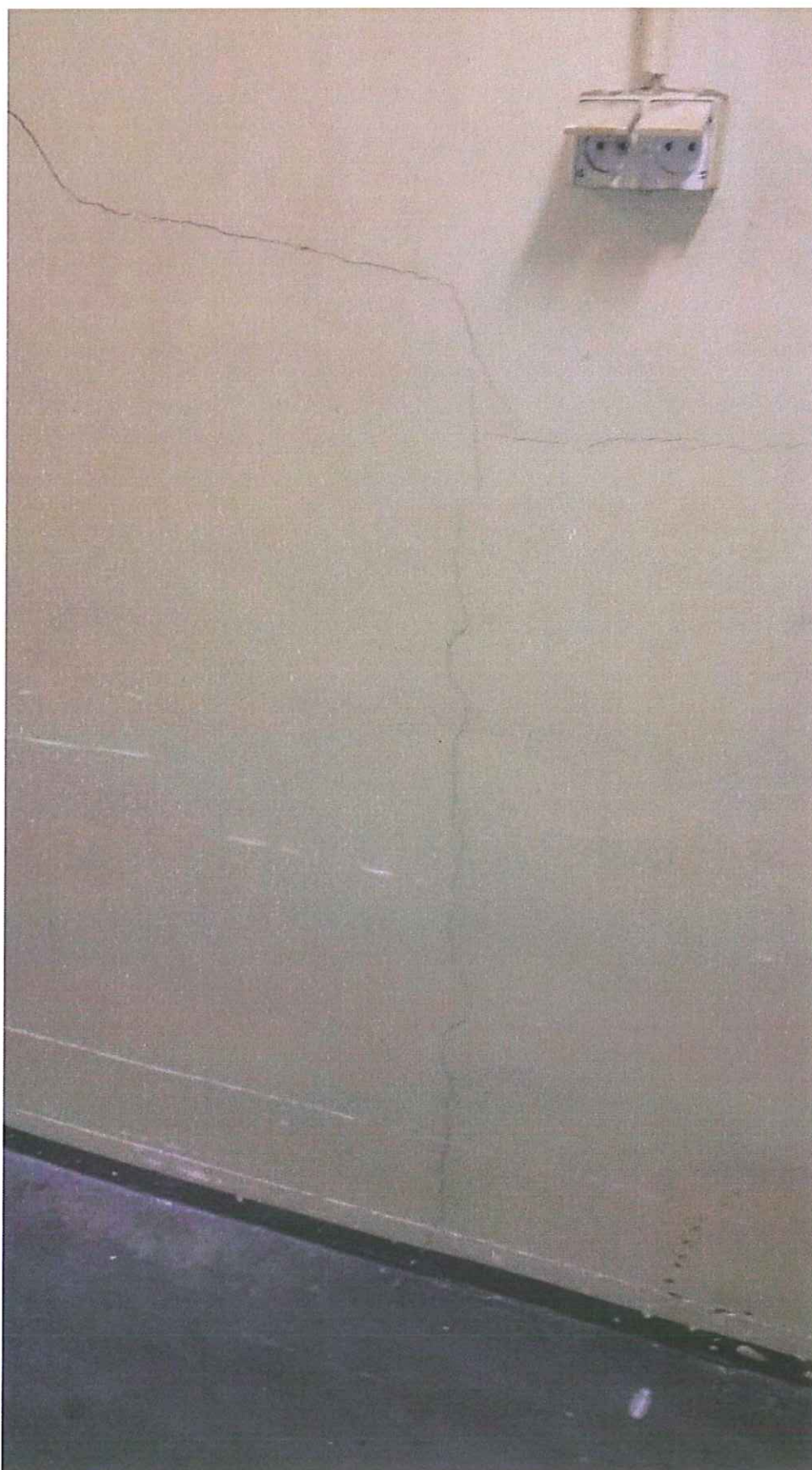
Fot. 10. Spękanie ściany piwnicy spowodowane nierównomiernym osiadaniem
