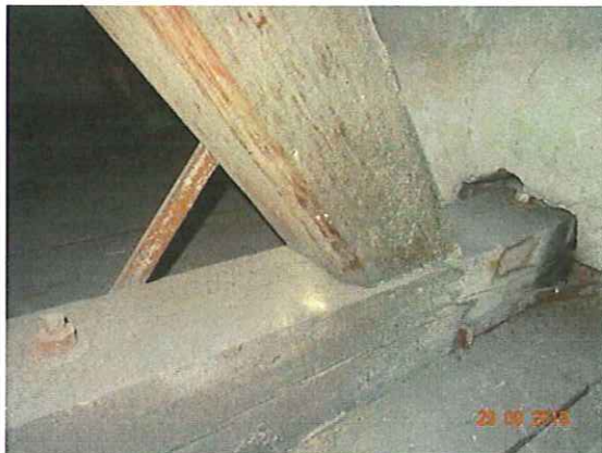
Fot. 12 Zbliżenie na świeże otwory wylotowe na krawędzi zastrzały konstrukcji wieszarowej. Widoczną również maczka na podwalinie ramy wieszarowej.
