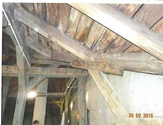
Fot. 18-13 Uszkodzenia korozyjne krokwi koszowej i opartych na niej krokwi kulawek.
