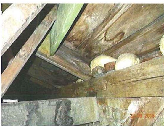
Fot. 23 Zniszczenia elementów więźby połaci frontowej i dawniejszym obecnym przy wlocie dachowym
