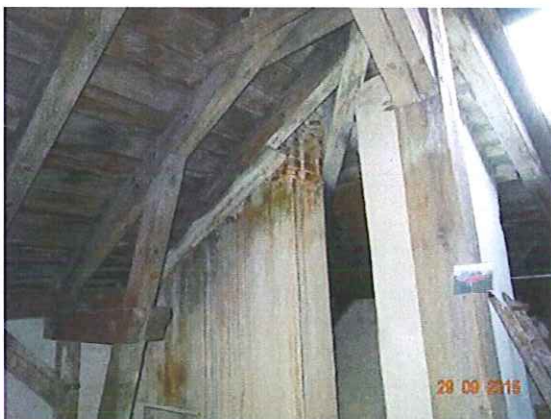
Fot. 26 Przykładowe ślady zawilgoceń na kominach „uszczelnione” pianką poliuretanową.
