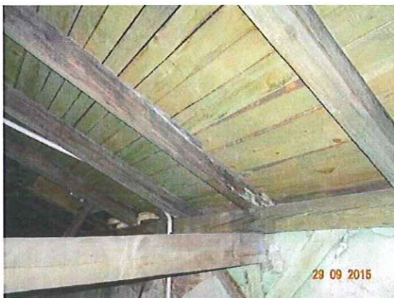
Fot. 20 Uszkodzony w wyniku zawilgocenia wodami opadowymi miecz ścianki kolankowej przy ścianie południowej lewego skrzydła budynku.
