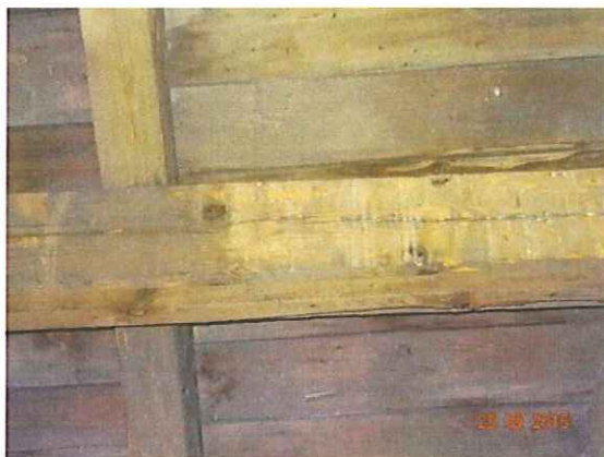
Fot. 7 Przykładowe uszkodzenia przez owady powierzchniowych warstw płaty pośrednich.
