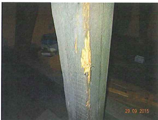
Fot. 10 Przykładowa odkrywka krawędzi słupa. Uszkodzone powierzchniowe warstwy drewna na głębokość ok. 0,5 cm.
