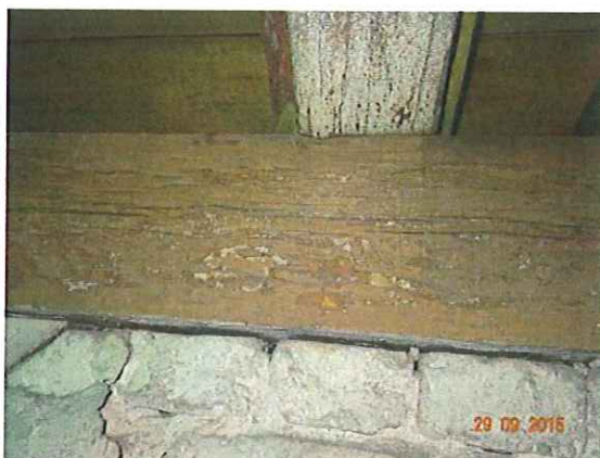
Fot. 5 Oczep ramy słpcowej traktu frontowego. Widoczne odstąpnięte i oczyszczone kanały larwalne. Powierzchnia pokryta impregnatem przeciwogniowym.
