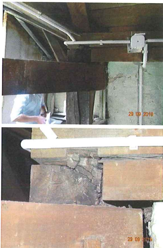
Fot. 27-18 Uszkodzone oparcia oczepów ścianek kolankowych w narożu ściany północnej lewego skrzydła budynku.
