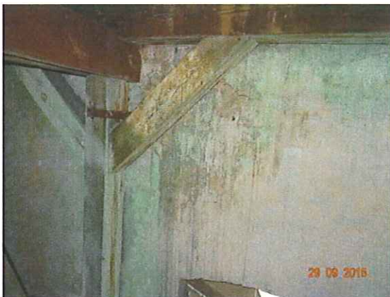
Fot. 20 Uszkodzony w wyniku zawilgocenia wodami opadowymi miecz ścianki kolankowej przy ścianie południowej lewego skrzydła budynku.
