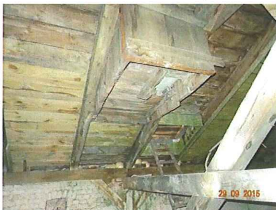
Fot. 22 Zniszczenia elementów więźby połaci frontowej i dawniejszym obecnym przy wlocie dachowym
