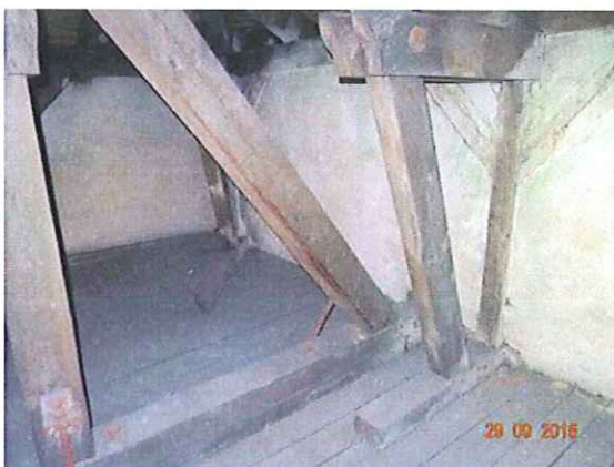
Fot. 11 Lokalizacja aktywnego porażenia drewna zastrzału konstrukcji wieszarowej przy ścianie południowej lewego skrzydła budynku.
