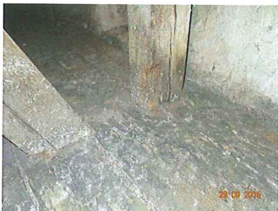
Fot. 15 Zniszczenia dolnej części drugiego słupa tylnej ścianki kolankowej licząc od ściany oddzielającej od prawego skrzydła budynku.
