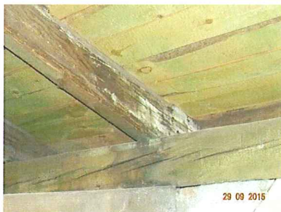
Fot. 31-21 Zniszczona końcówka krokwi połaci frontowej.
