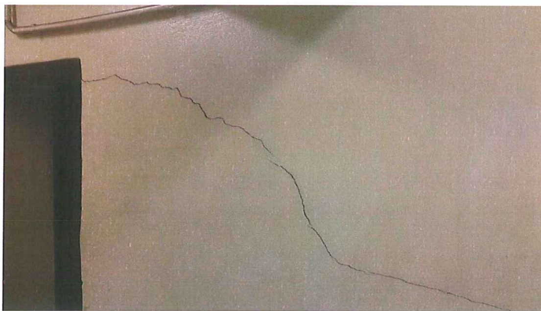
Fot. 9. Spękanie ściany piwnicy spowodowane nierównomiernym osiadaniem
