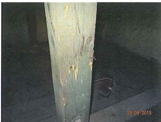
Fot. 7 Przykładowe uszkodzenia przez owady powierzchniowych warstw płaty pośrednich.
