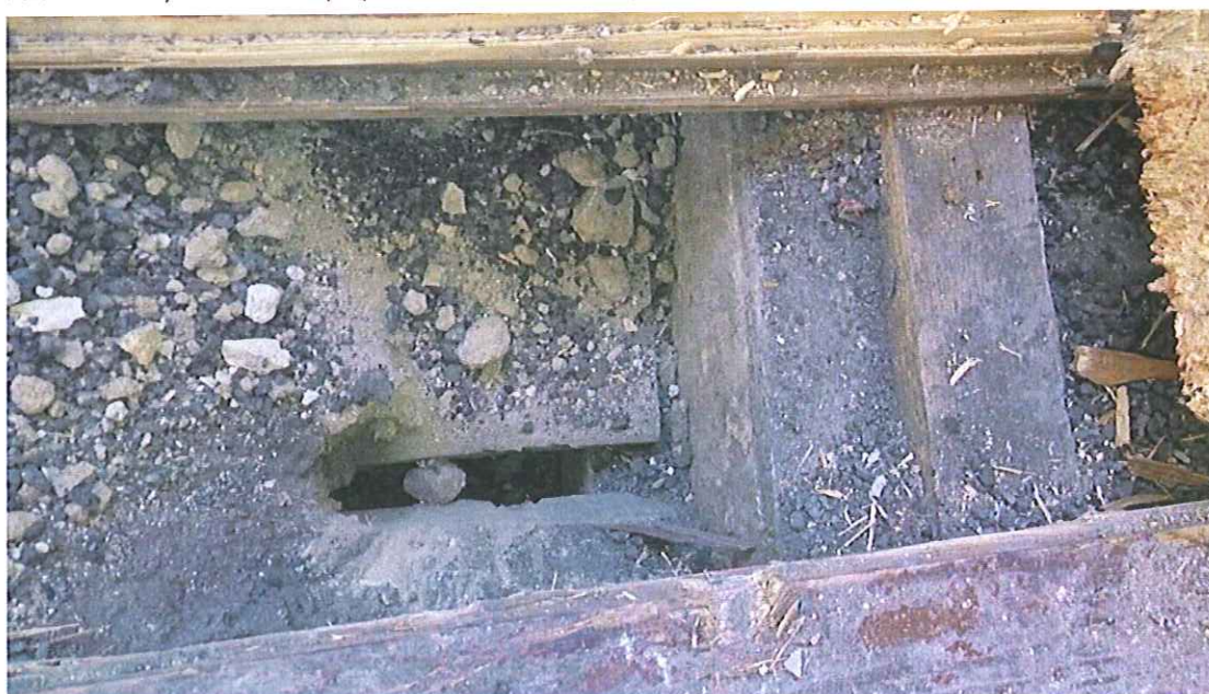
Fot. 13. Odkrywka nr 07 stropu pomieszczenia biurowego- belka stropowa 16x30 cm
