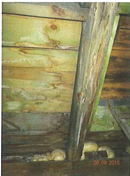
Fot. 24 Zniszczenia elementów więźby połaci frontowej i dawniejszym obecnym przy włazie dachowym
