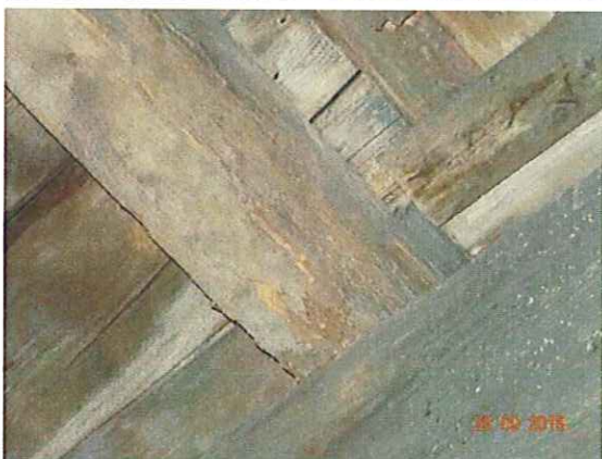
Fot. 9-6 Przykładowe uszkodzenia przez owady powierzchniowych warstw krokwi.
