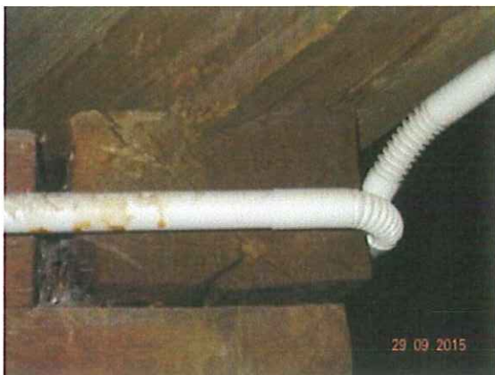
Fot. 19 Uszkodzone oparcia oczepów ścianek kolankowych w narożu ściany północnej lewego skrzydła budynku.
