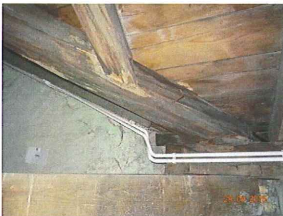
Fot. 12 Zbliżenie na świeże otwory wylotowe na krawędzi zastrzały konstrukcji wieszarowej. Widoczną również maczka na podwalinie ramy wieszarowej.
