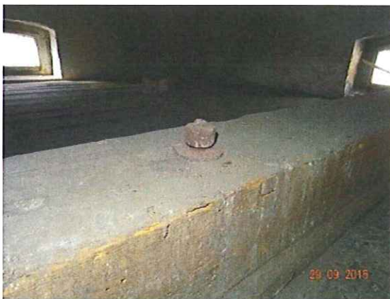
Fot. 25 Przykład rozluźnienia połączenia śrubowego, którym do podwalin ścianek wieszarowych podwieszone są belki stropowe.
