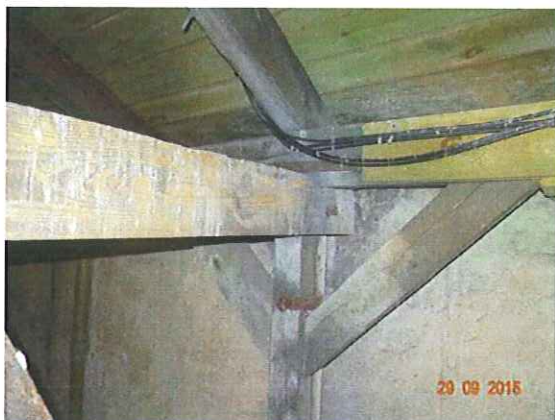
Fot. 9 Przykładowe uszkodzenia przez owady powierzchniowych warstw kleszczy.
