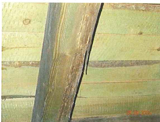
Fot. 5 Oczep ramy słpcowej traktu frontowego. Widoczne odstąpnięte i oczyszczone kanały larwalne. Powierzchnia pokryta impregnatem przeciwogniowym.
