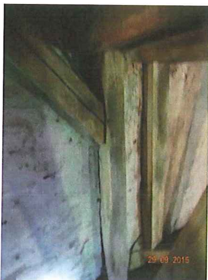
Fot. 25-17 Zniszczenia słupa ścianki kolankowej skrzydła lewego położonego na przedłużeniu ściany tylnej budynku frontowego.
