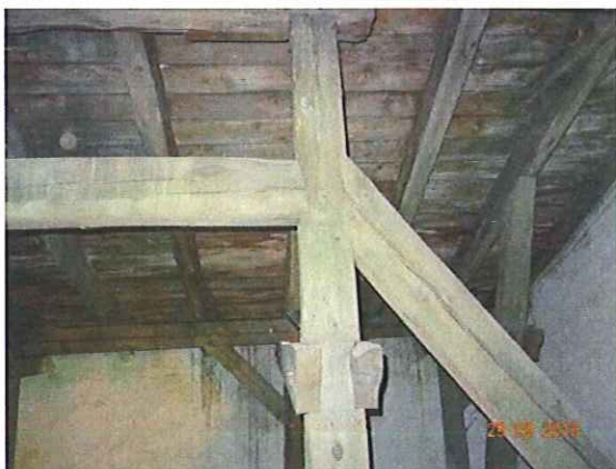
Fot. 12-8 Przykładowe uszkodzenia przez owady powierzchniowych warstw słupów.
