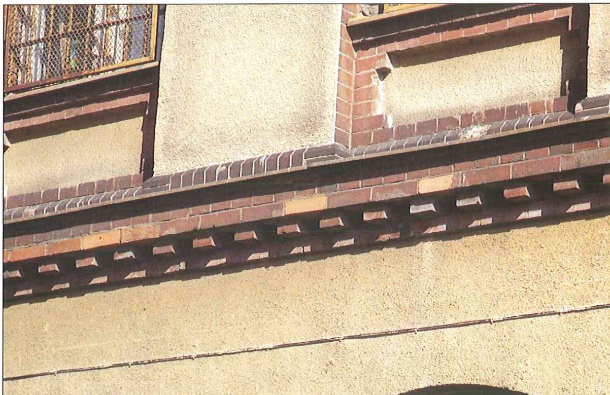
Fot. 12 Gzyms podokienny, ceglany, elewacja południowa, I. piętro
