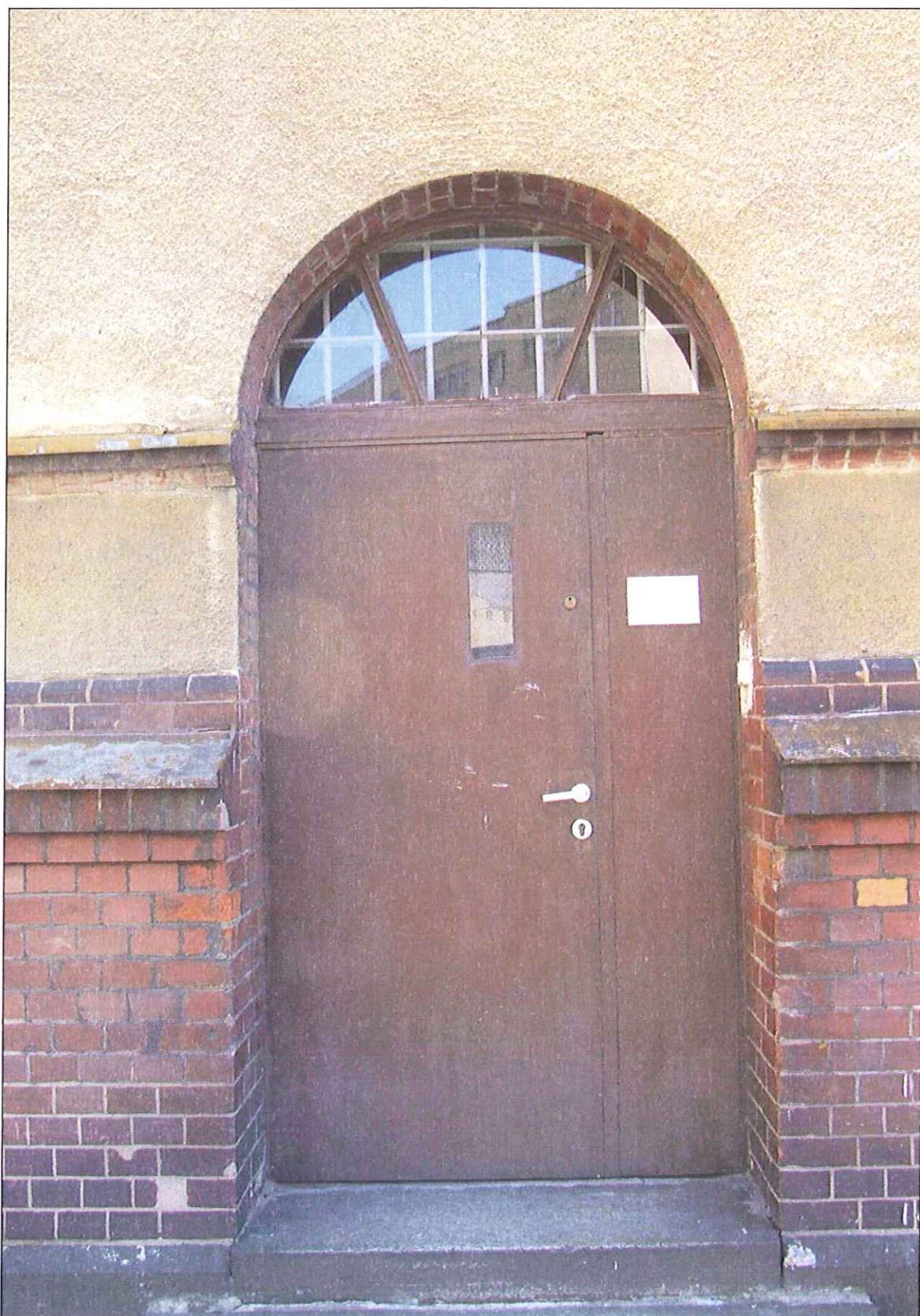
Fot. 46 Drzwi zewnętrzne do wymiany(dziedziniec)
