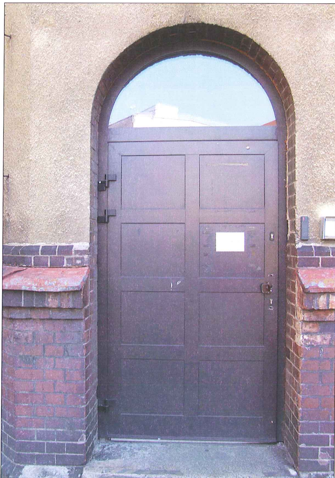
Fot. 45 Drzwi zewnętrzne do wymiany(dziedziniec)
