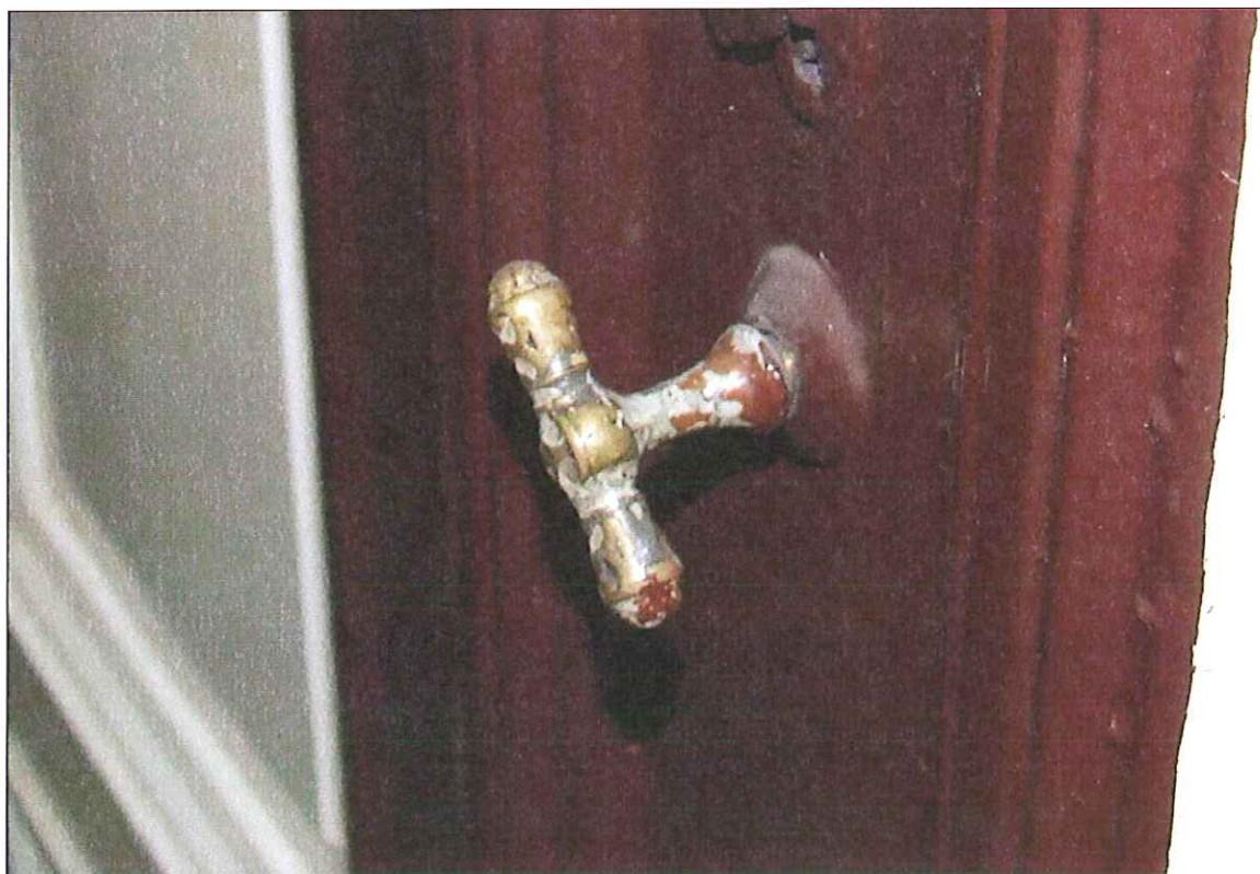
Fot. 49 Stołarka drzwiowa wewnętrzna, oryginalna (okucia)
