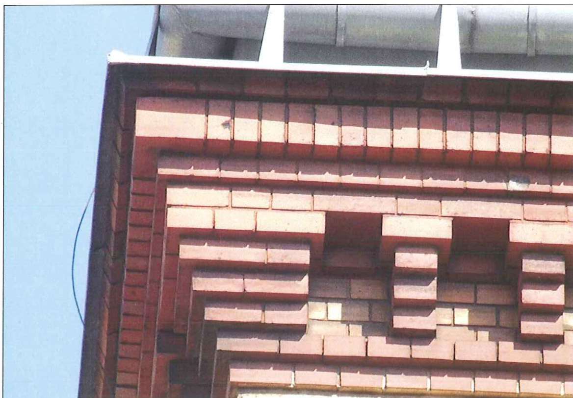
Fot. 14 Gzyms Główny, ceglany, elewacja zachodnia
