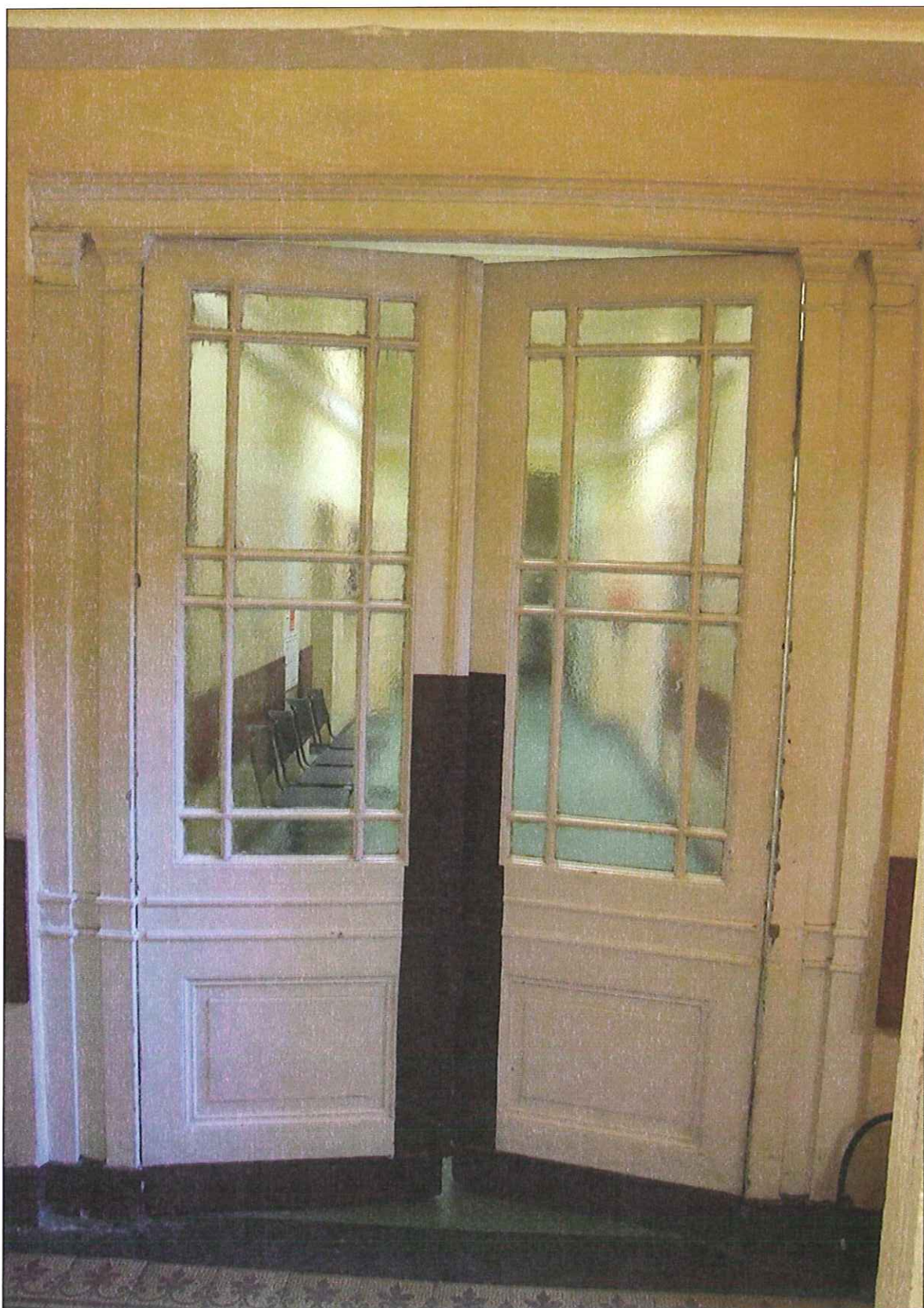
Fot. 51 Stolarka drzwiowa wewnętrzna, oryginalna
