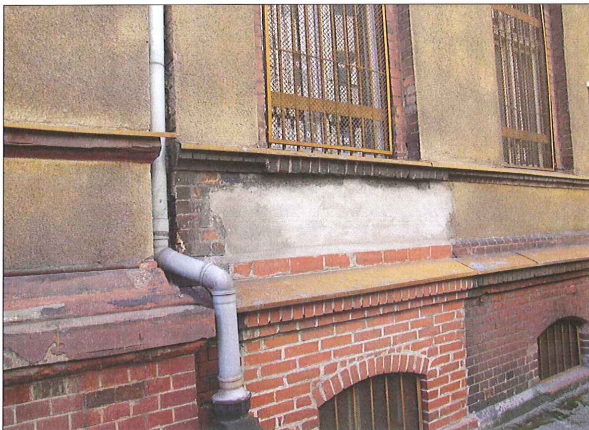
Fot. 28 Uszkodzenia tynku
