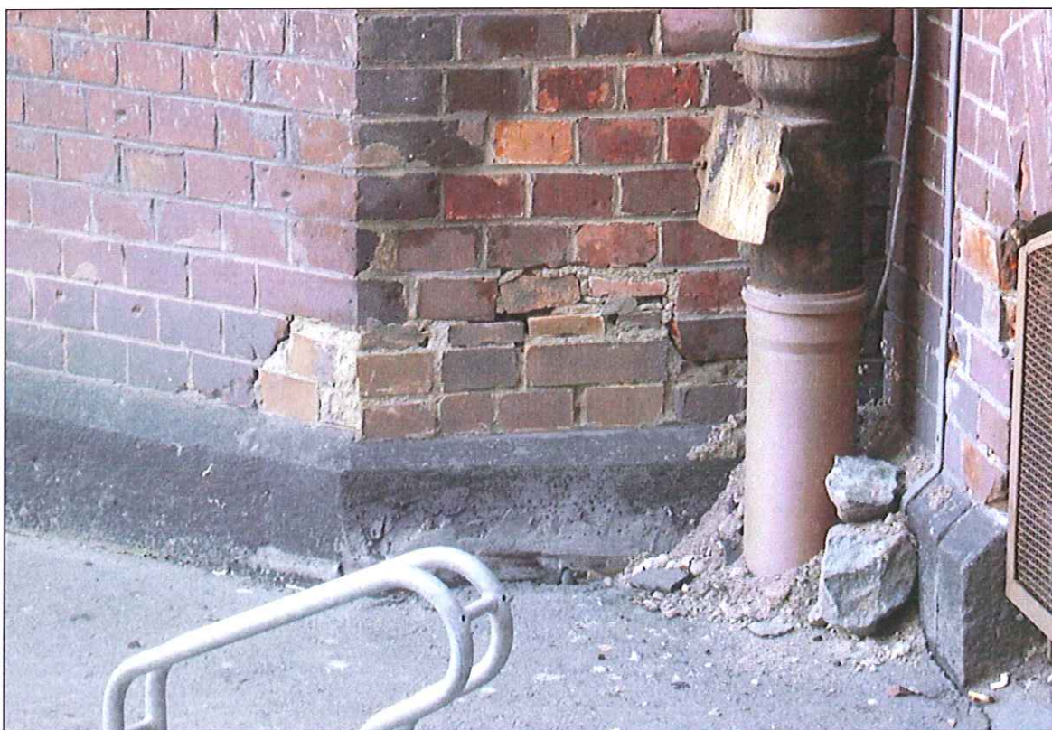
Fot. 30 Uszkodzenia muru ceglanego
