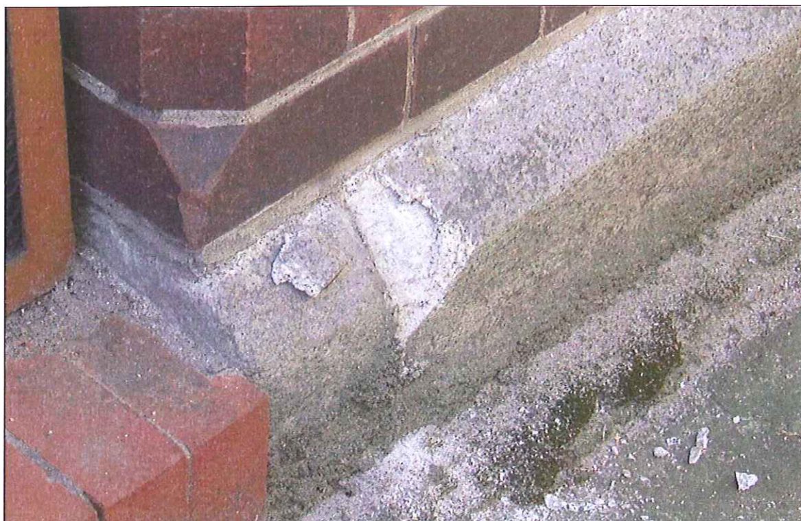
Fot. 34 Uszkodzenia detalu kamiennego
