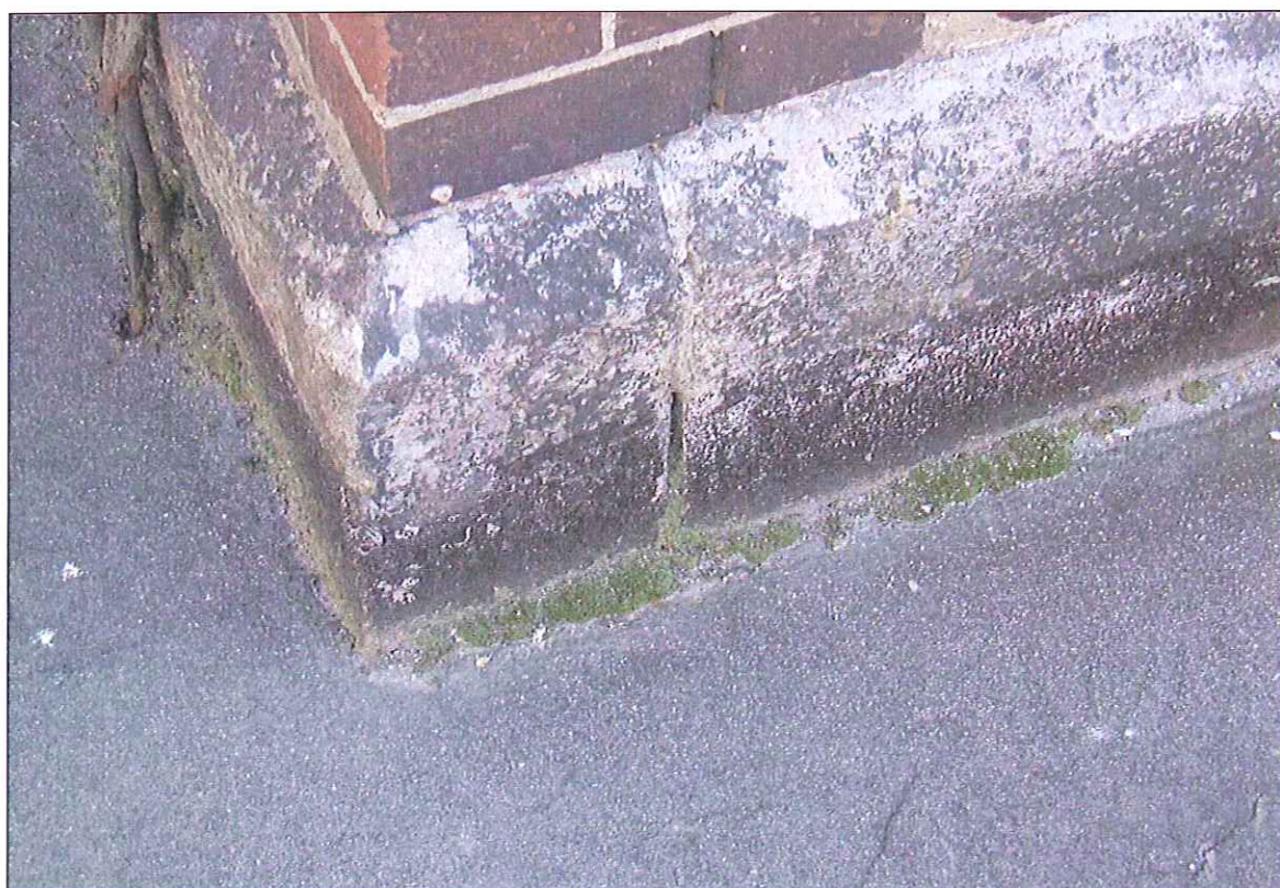
Fot. 35 Uszkodzenia detalu kamiennego
