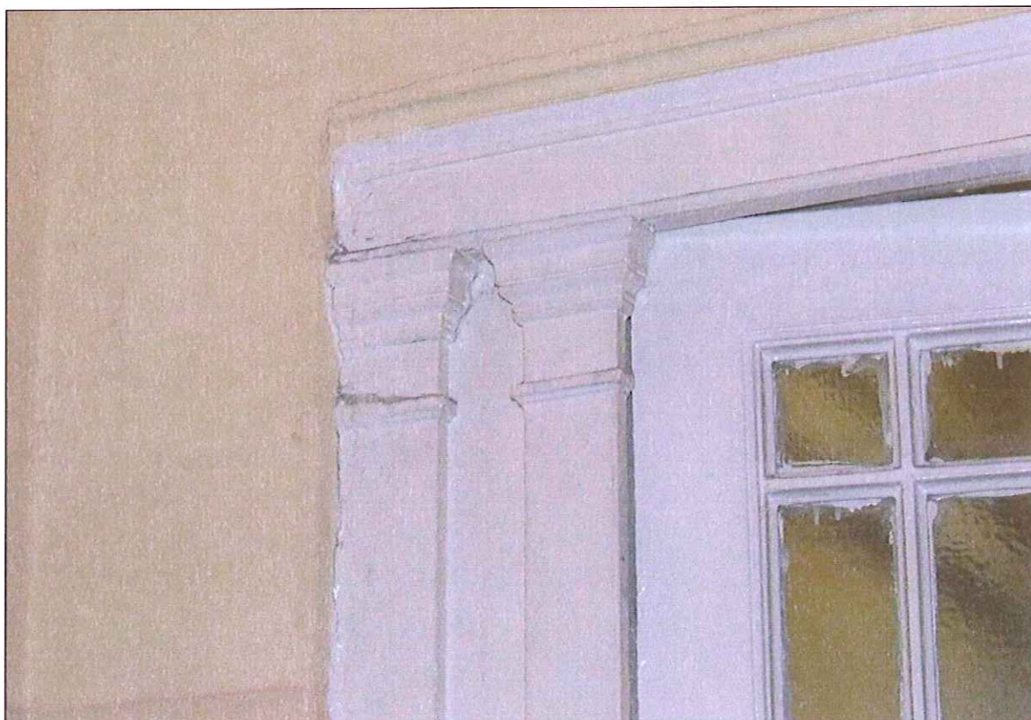
Fot. 52 Stolarka drzwiowa wewnętrzna, oryginalna (detal)
