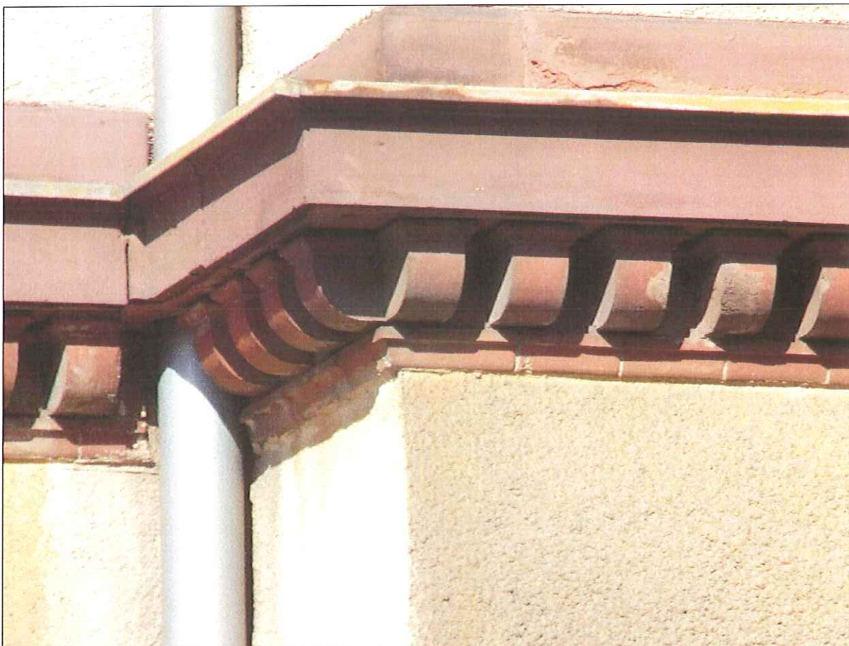
Fot. 11 Elewacja frontowa, gzyms podokienny, I. piętro, (szczegół)
