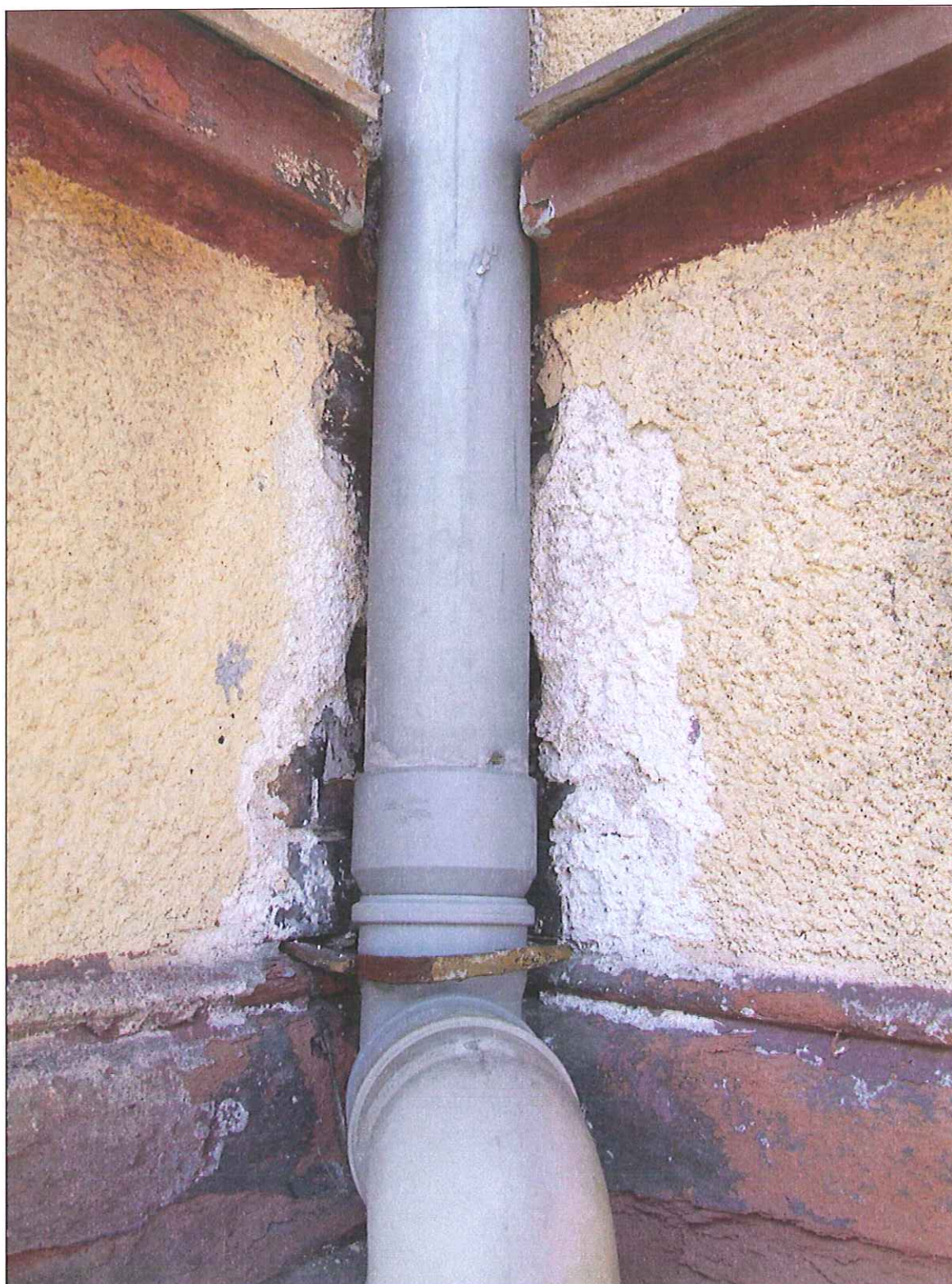
Fot. 26 Uszkodzenia tynku
