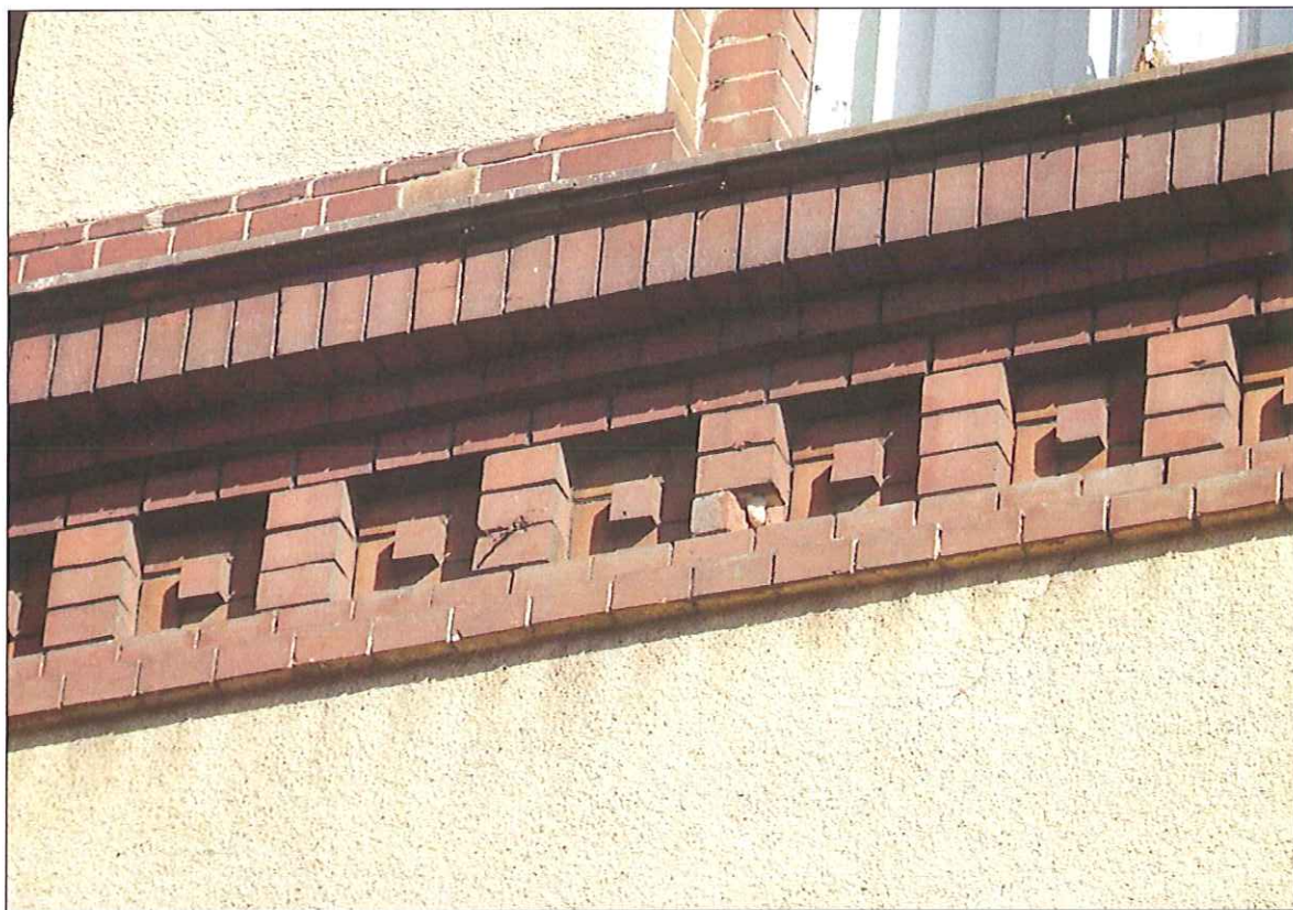
Fot. 13 Gzyms podokienny, ceglany, elewacja południowa, II. piętro
