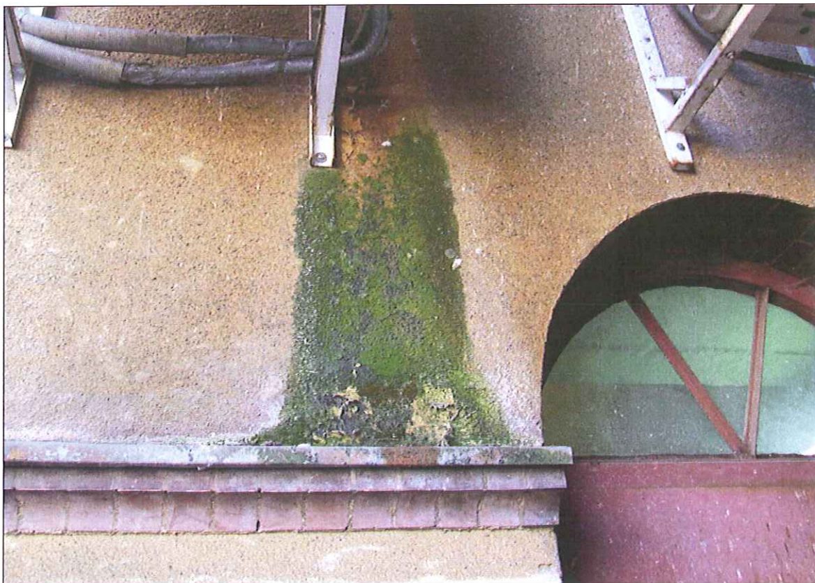
Fot. 27 Uszkodzenia tynku (skażenie mikroflorą)
