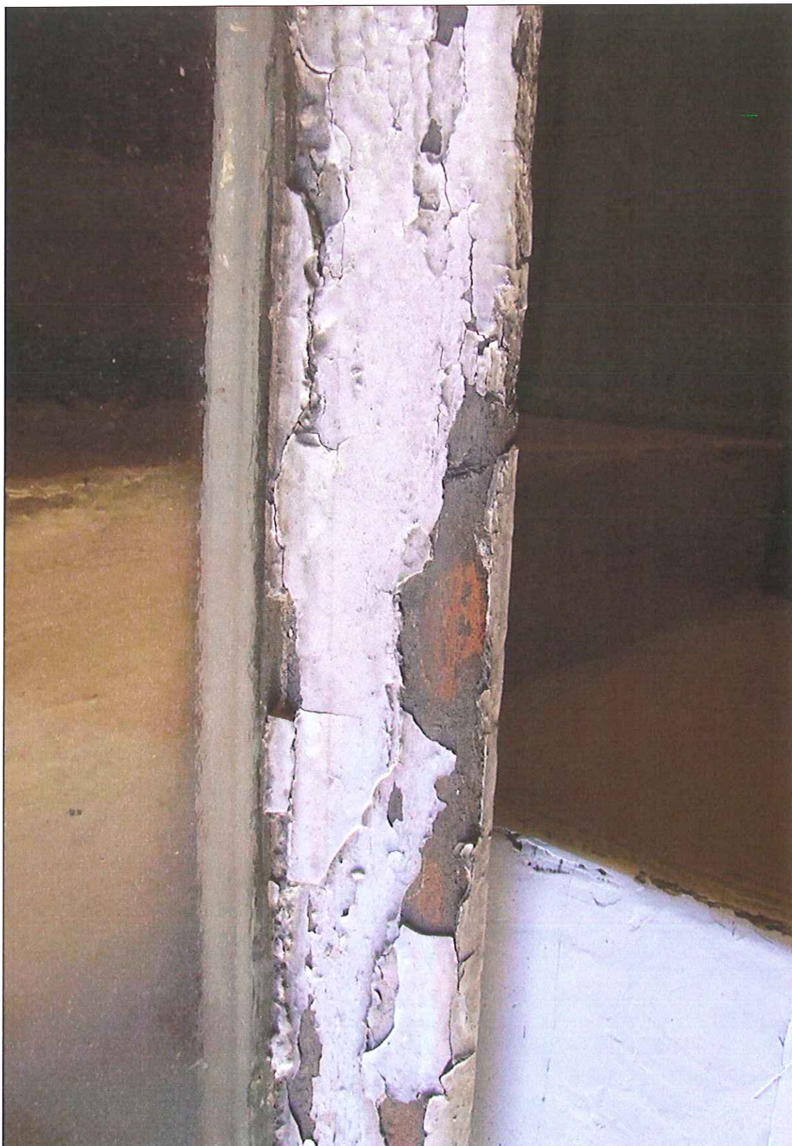
Fot. 39 Oryginalna stolarka okienna, uszkodzenia
