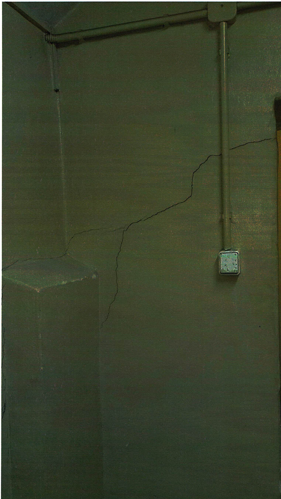
Fot. 11. Spękanie ściany piwnicy spowodowane nierównomiernym osiadaniem
