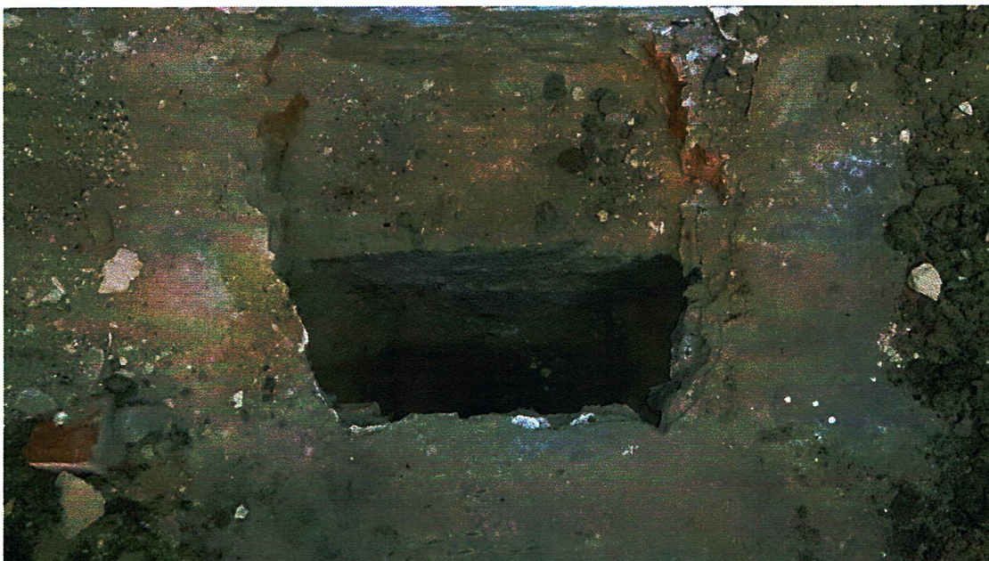
Fot. 3. Odkrywka fundamentu od wewnątrz w miejscu projektowanej windy
