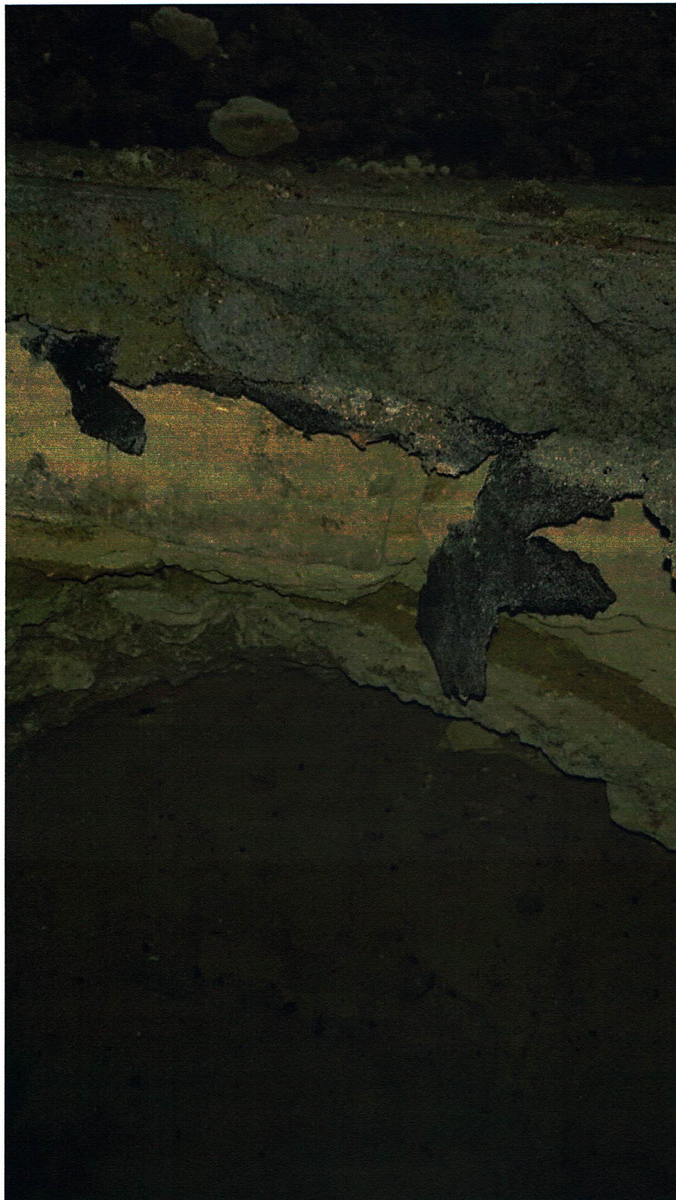
Fot. 6. Odkrywka warstw posadzki na gruncie w pomieszczeniu, do którego będzie przylegać projektowana winda
