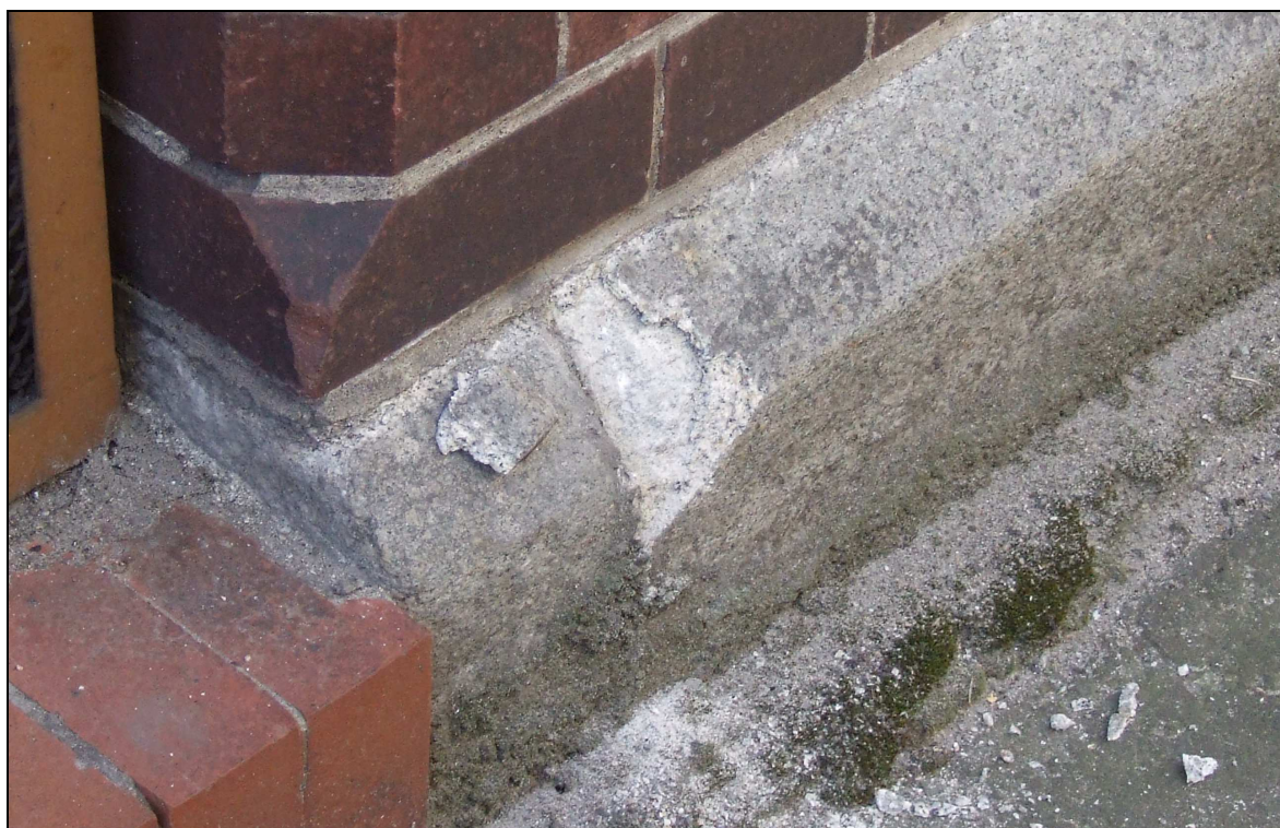
Fot. 34 Uszkodzenia detalu kamiennego
