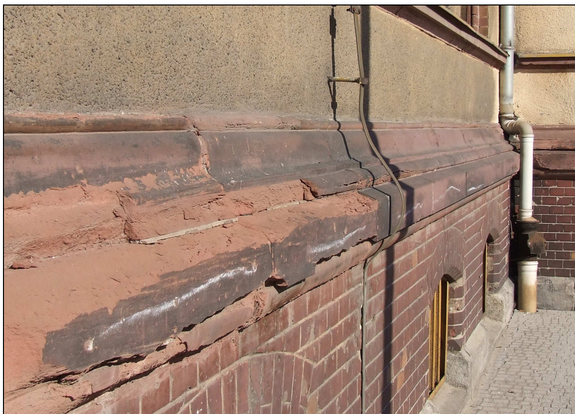
Fot. 31 Uszkodzenia detalu, gzyms cokotowy
