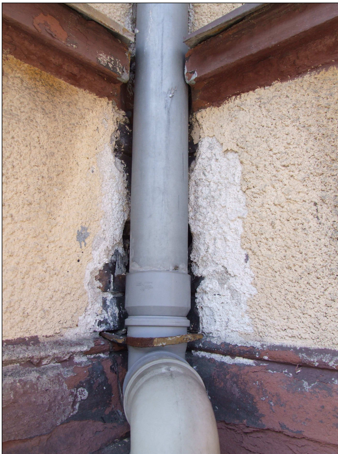
Fot. 26 Uszkodzenia tynku
