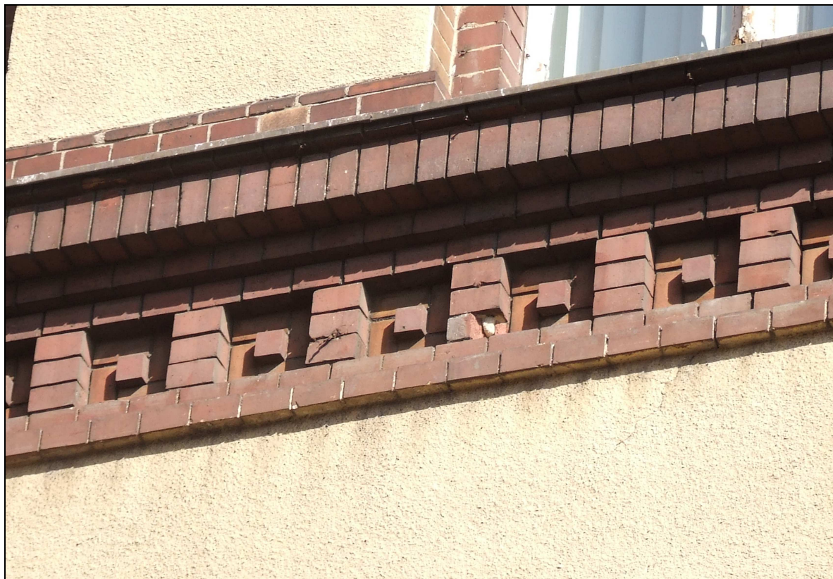
Fot. 13 Gzymś podokienny, ceglany, elewacja południowa, II. piętro
