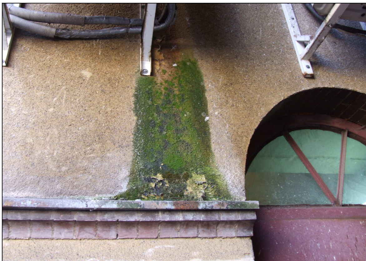
Fot. 27 Uszkodzenia tynku (skażenie mikroflorą)
