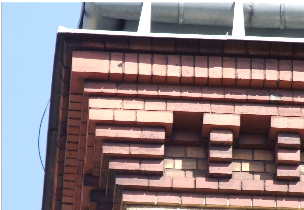
Fot. 14 Gzymś Główny, ceglany, elewacja zachodnia
