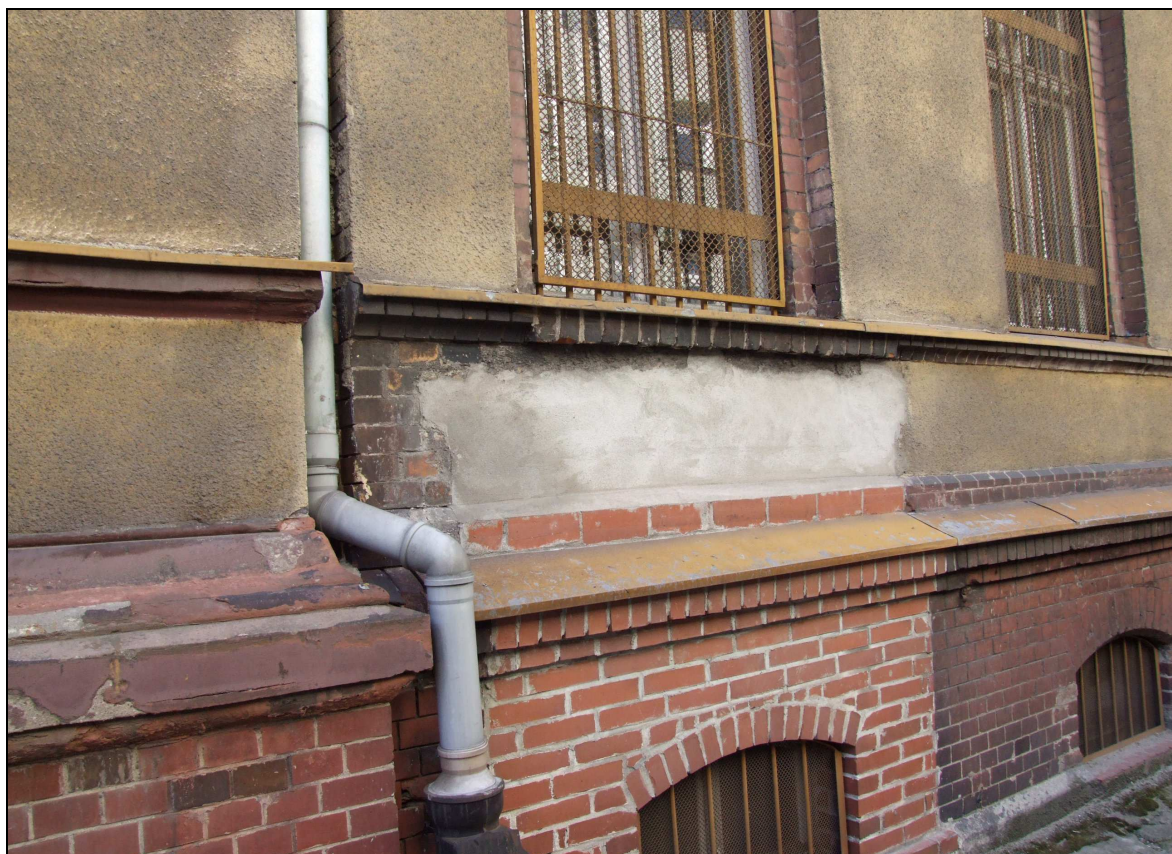
Fot. 28 Uszkodzenia tynku
