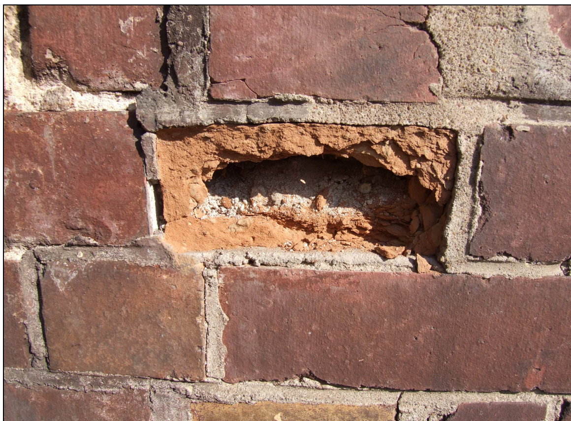
Fot. 29 Uszkodzenia muru ceglanego
