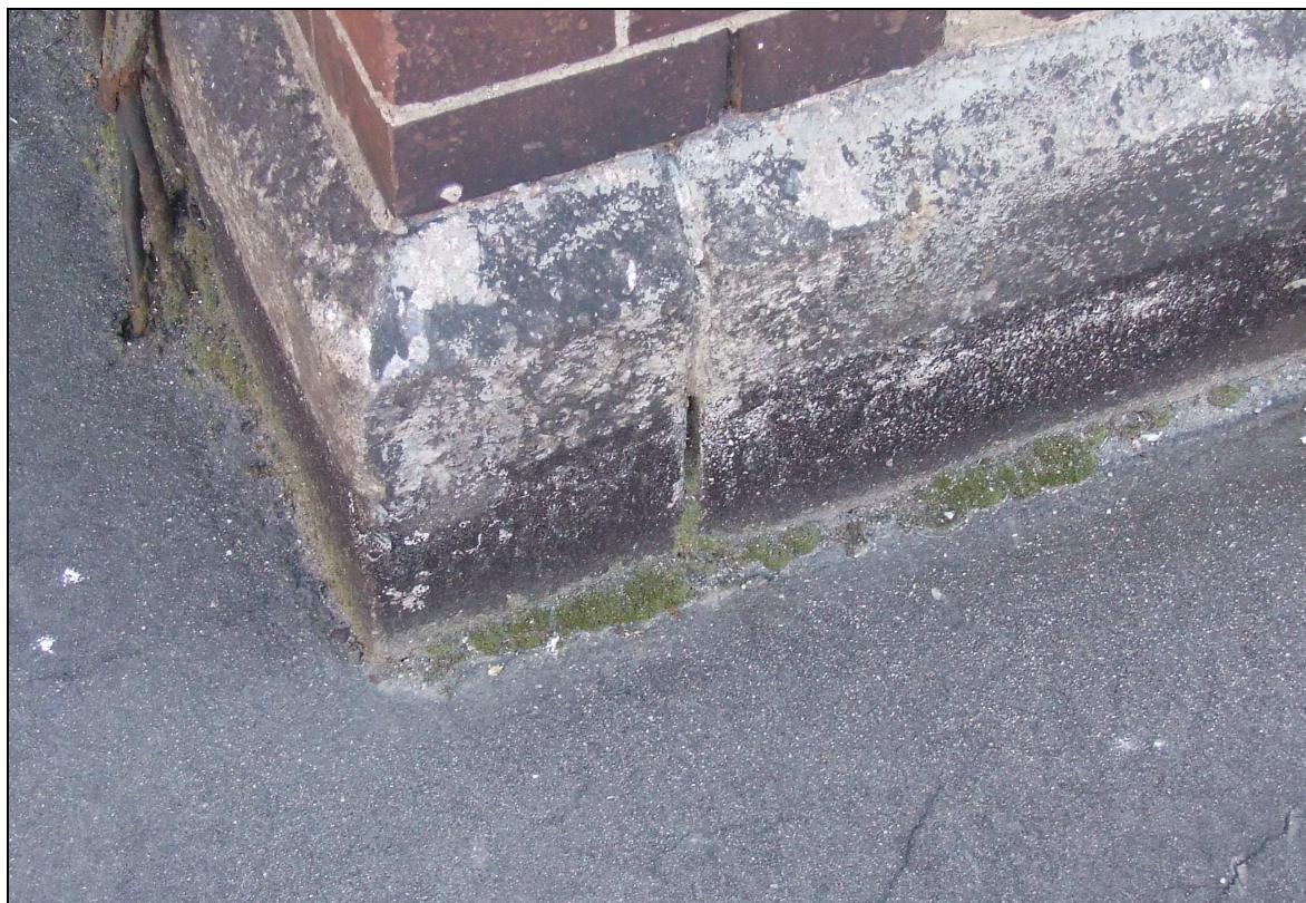
Fot. 35 Uszkodzenia detalu kamiennego
