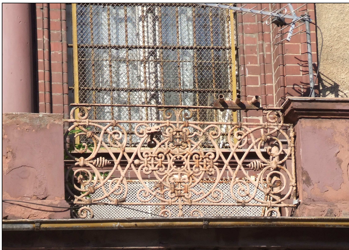
Fot. 32 Uszkodzenia detalu, taras
