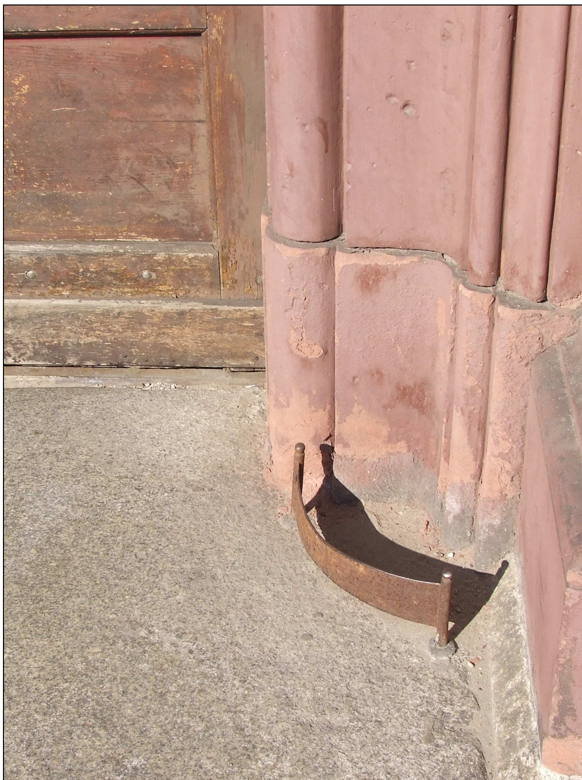
Fot. 33 Uszkodzenia detalu, portal wejściowy
