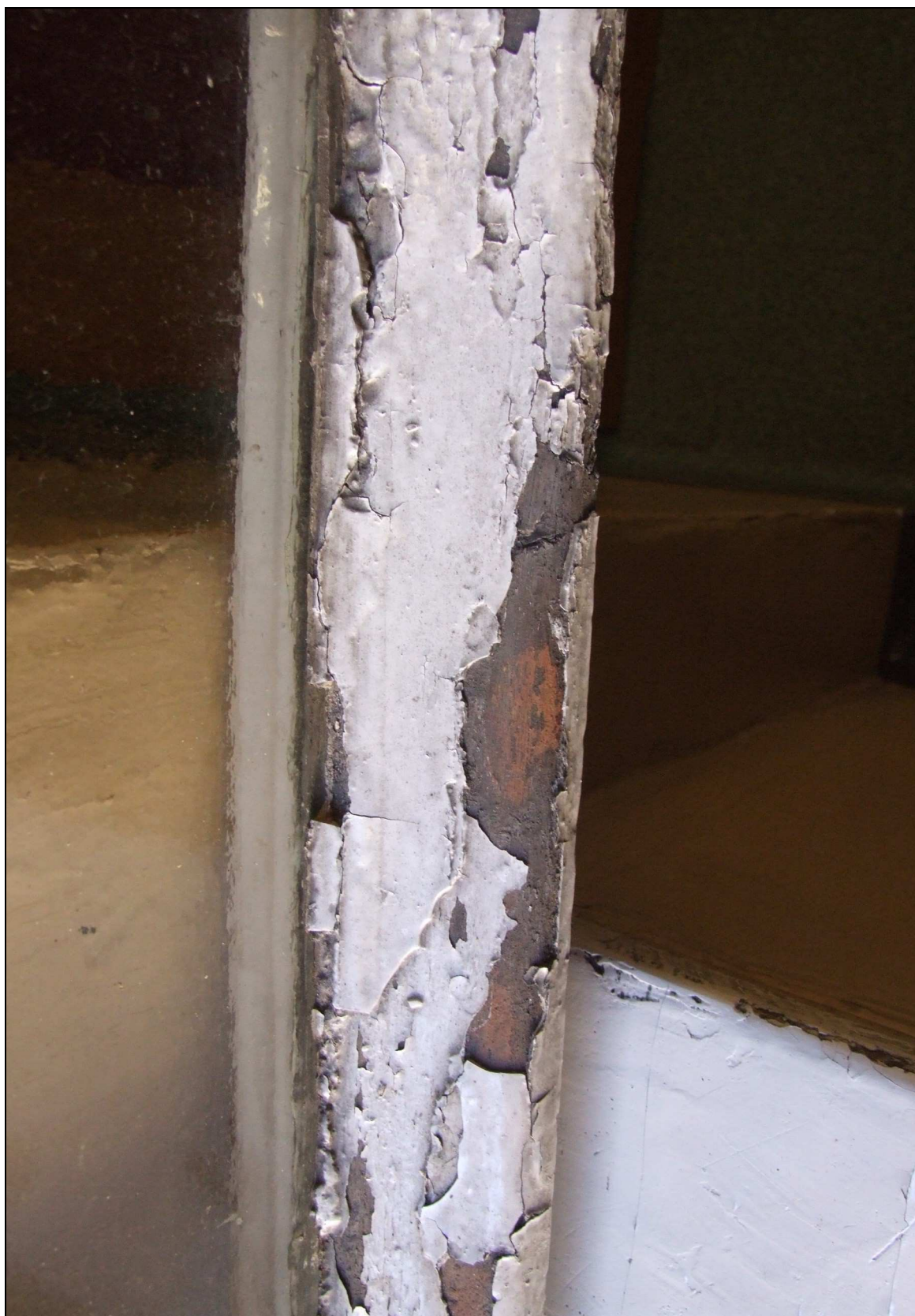
Fot. 39 Oryginalna stolarka okienna, uszkodzenia
