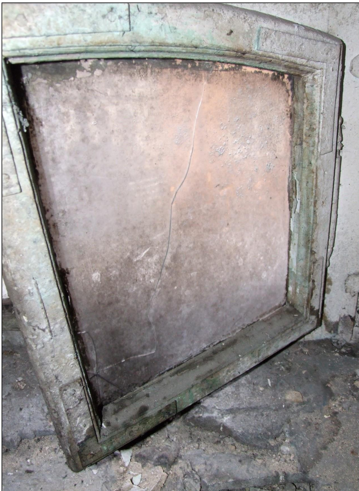
Fot. 32 Okno typu O3, uszkodzenia – poddasze, elewacja południowa
