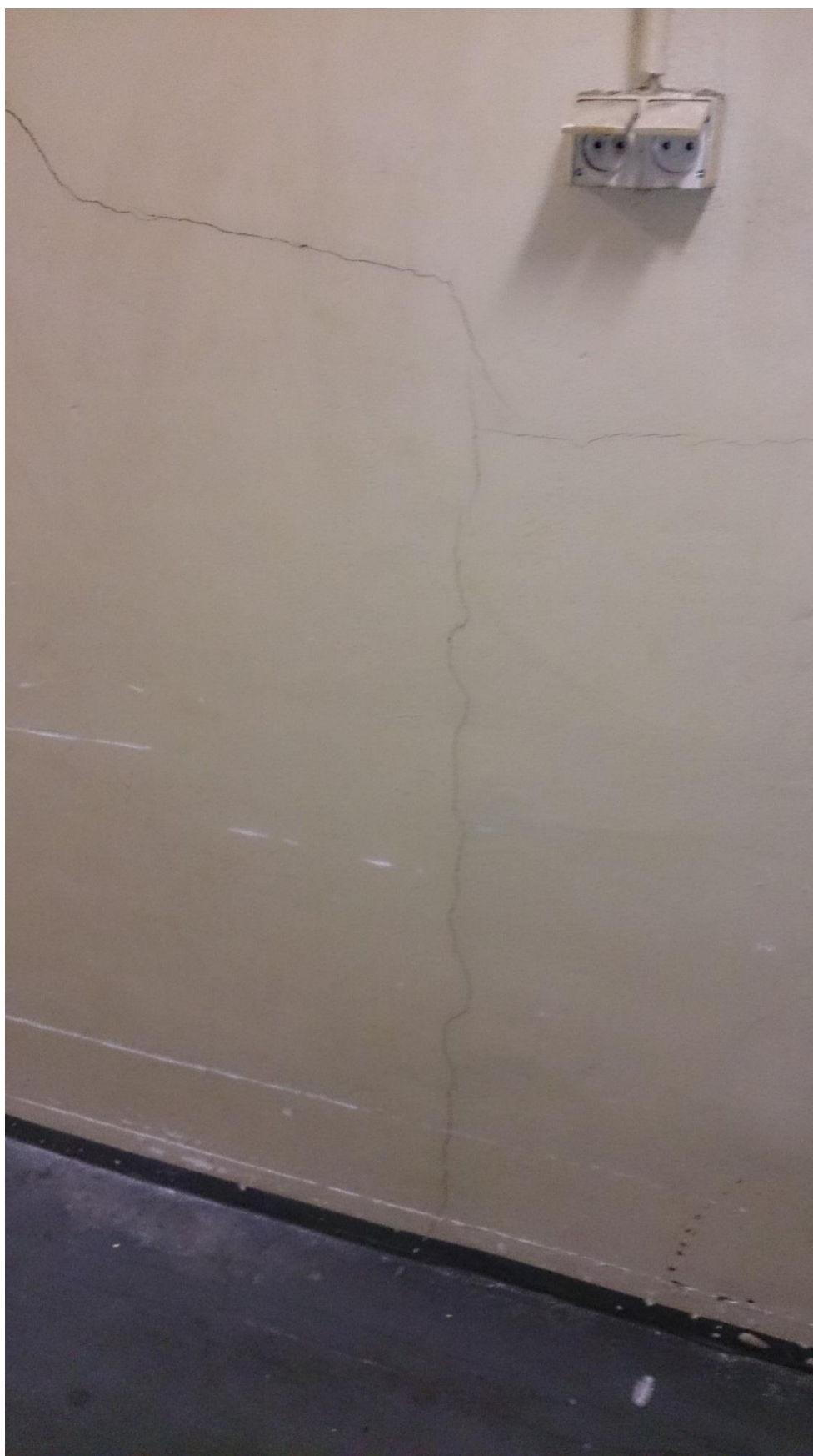
Fot. 10. Spękanie ściany piwnicy spowodowane nierównomiernym osiadaniem
