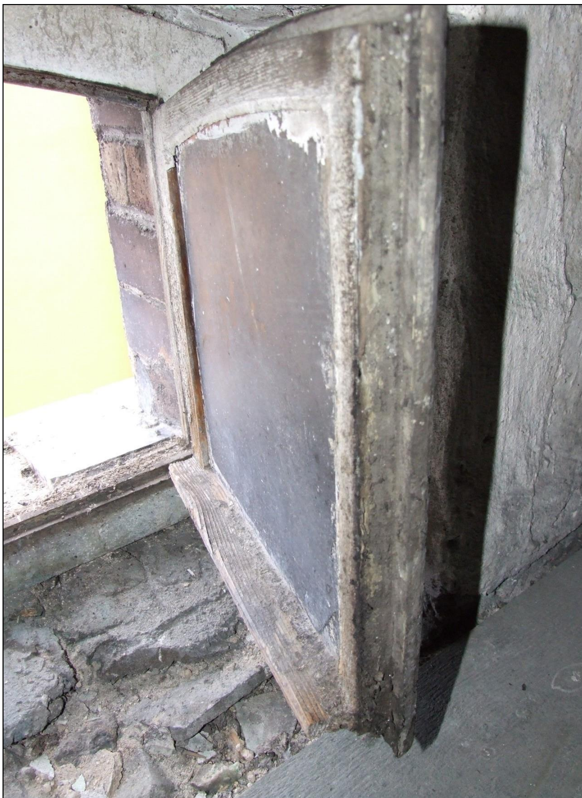
Fot. 33 Okno typu O3, uszkodzenia – poddasze, elewacja południowa
