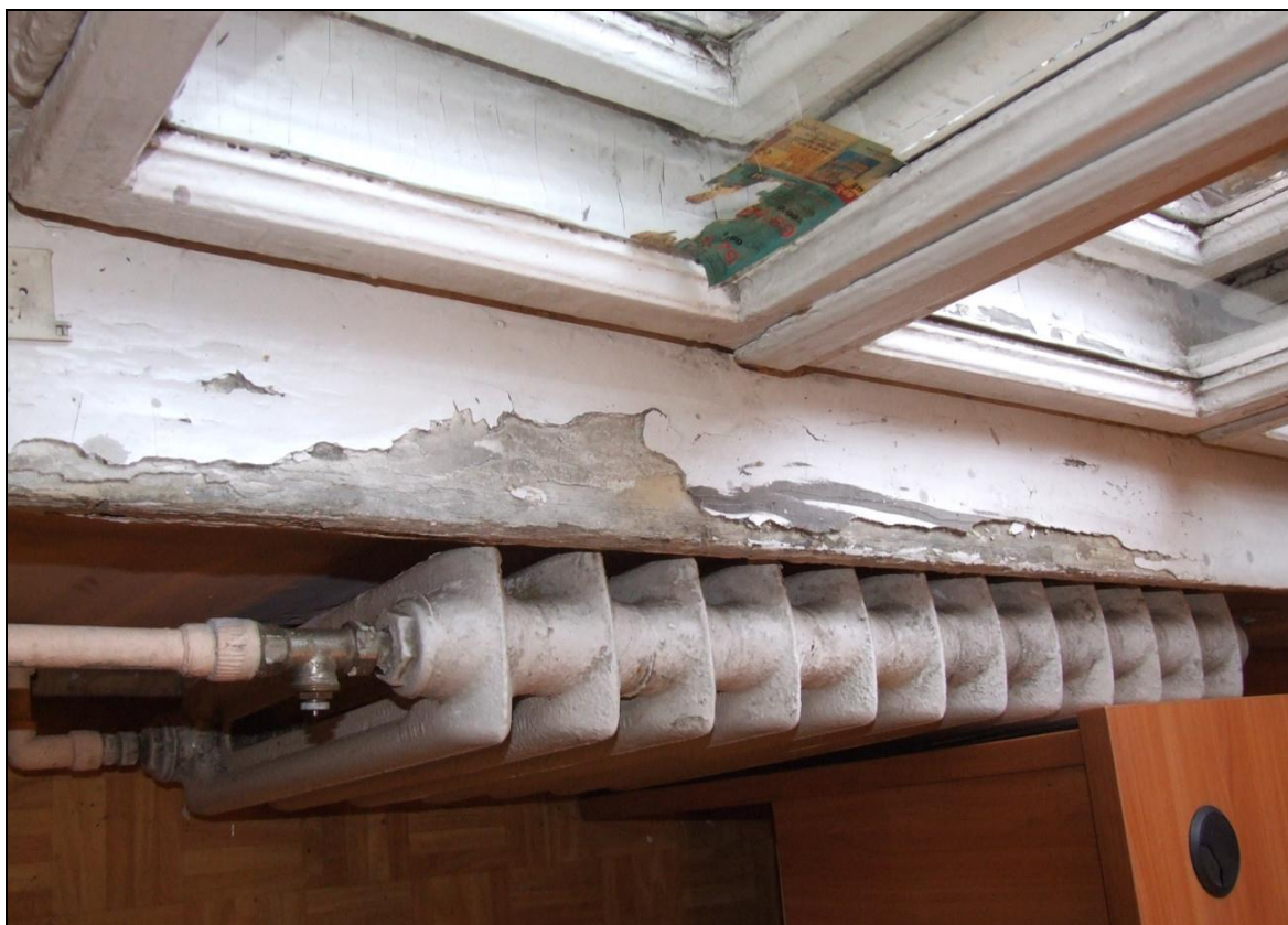
Fot. 15 Okno typu O1 a, uszkodzenia – elewacja południowa
