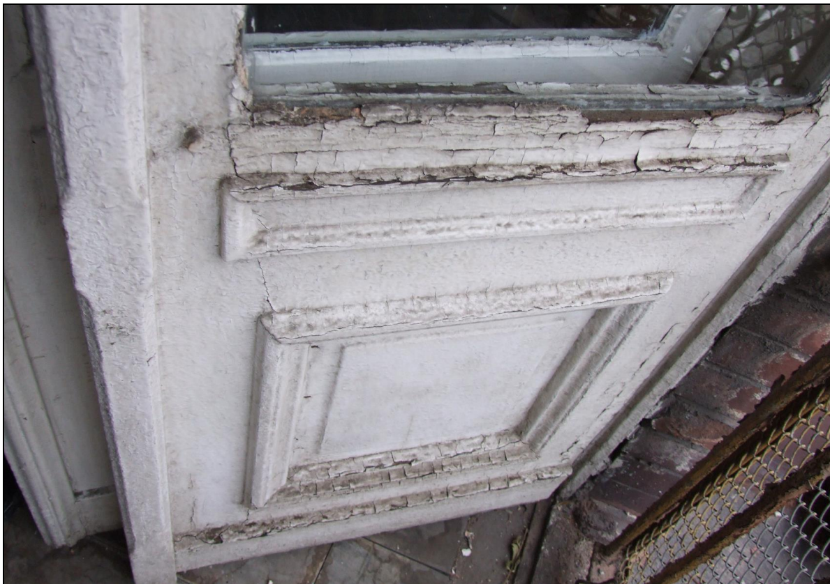
Fot. 20 Drzwi balkonowe typu O1 b, uszkodzenia – elewacja wschodnia
