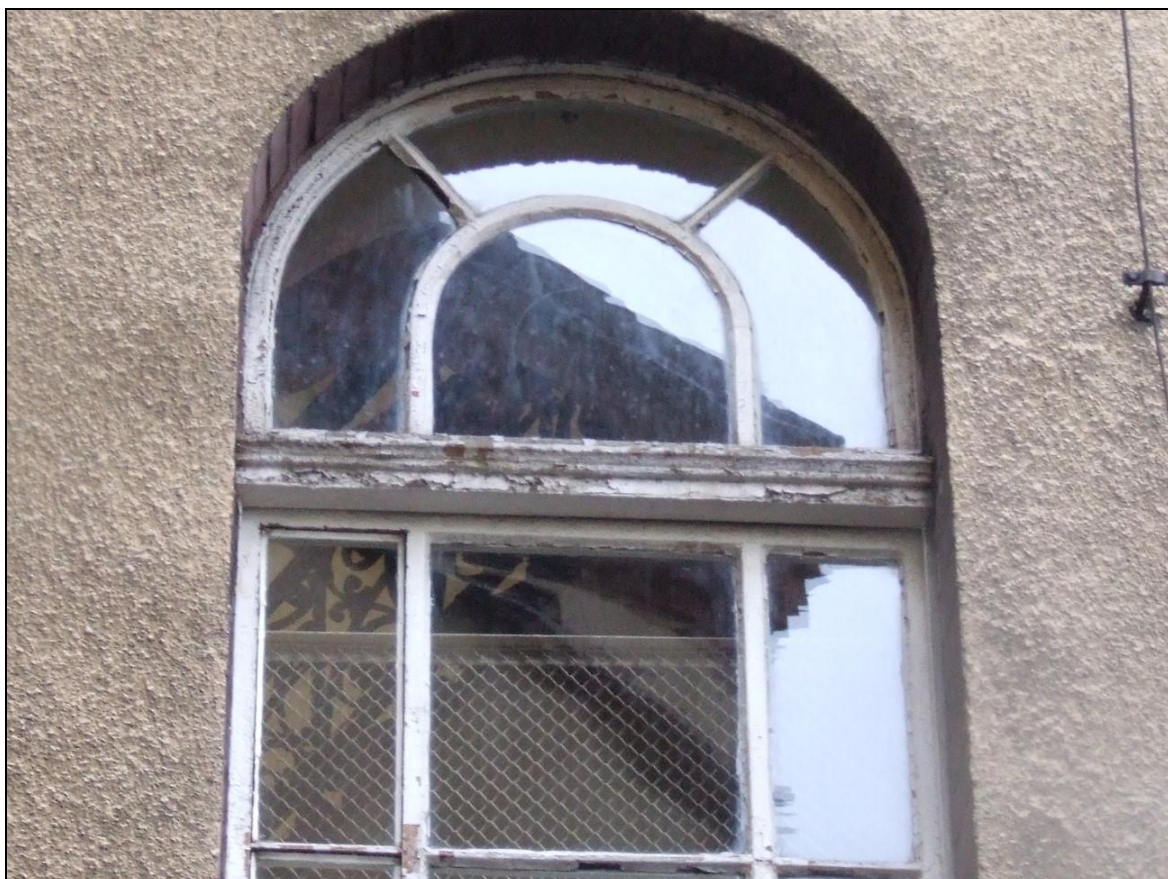
Fot. 26 Okno typu O2, uszkodzenia – elewacja zachodnia
