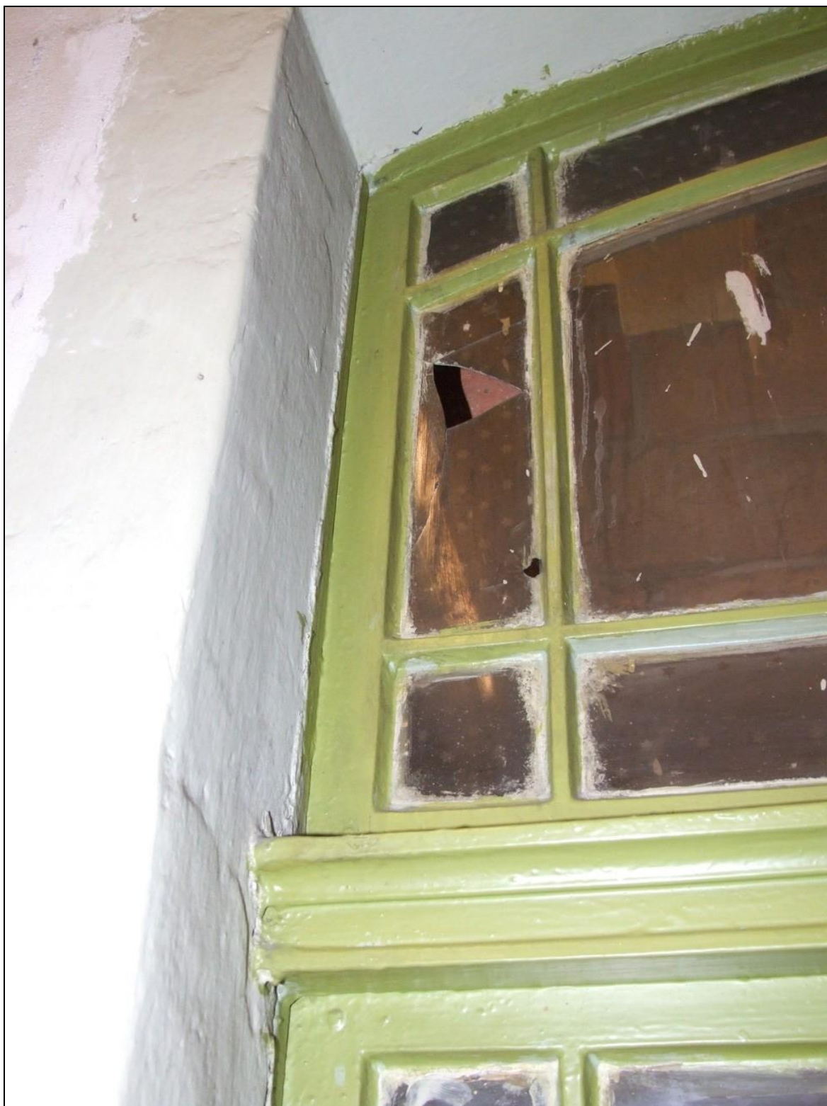
Fot. 52 Okno wewnętrzne typu O9, uszkodzenia - boczna klatka schodowa
