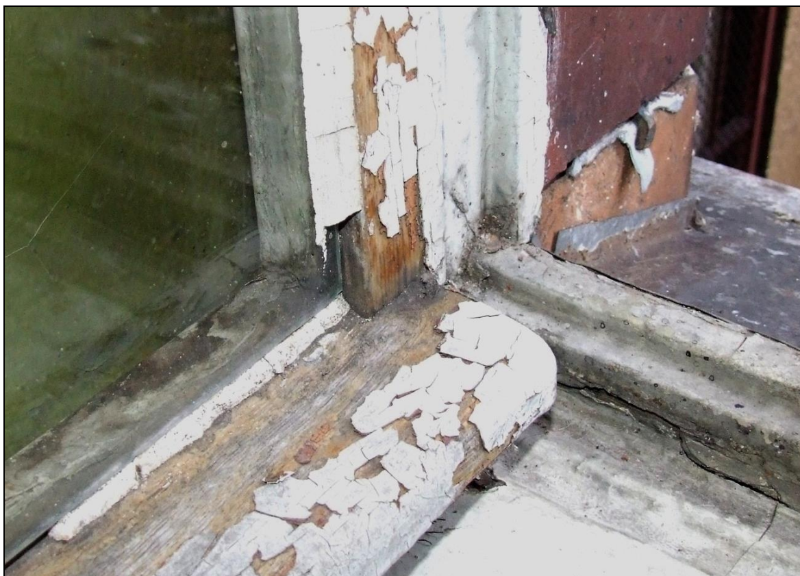
Fot. 49 Okna typu O8, uszkodzenia – boczna klatka schodowa
