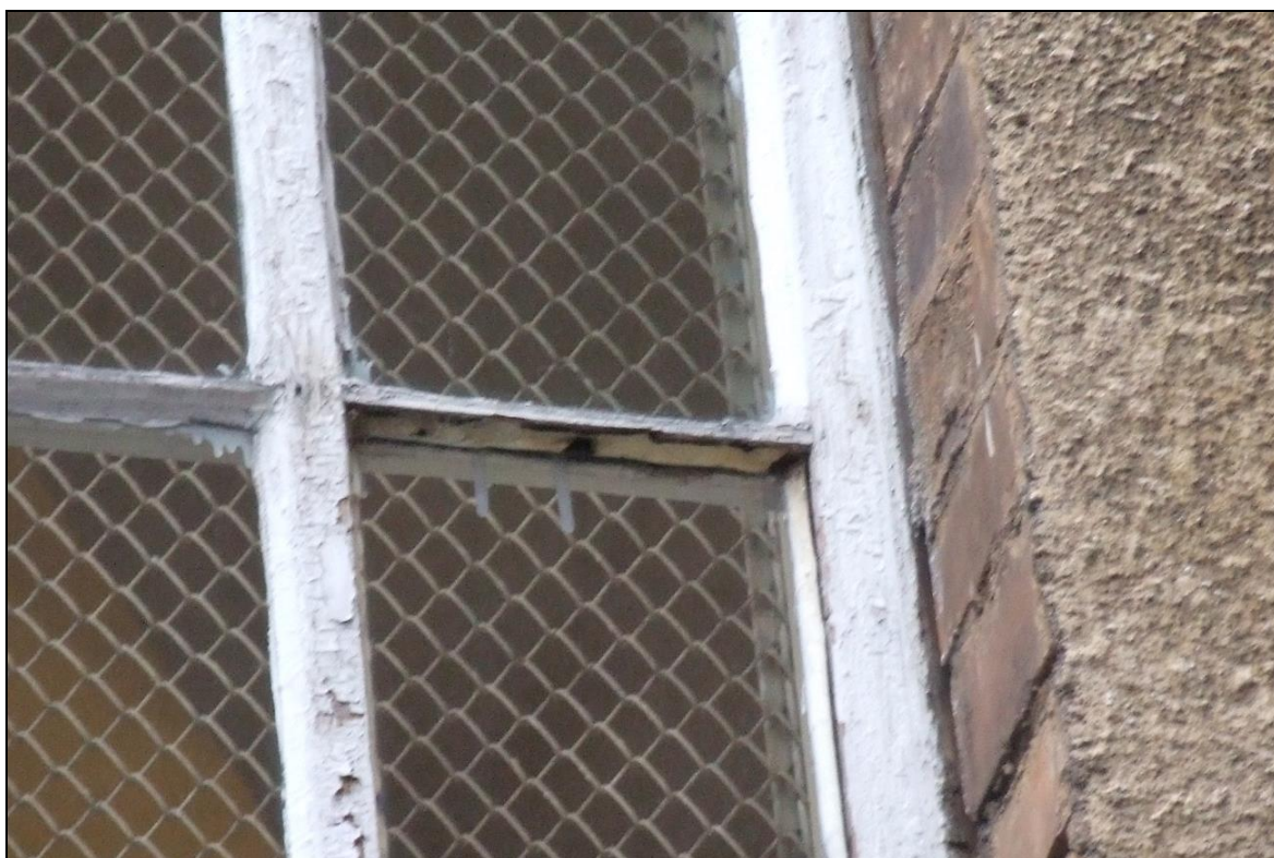
Fot. 27 Okno typu O2, uszkodzenia – elewacja zachodnia
