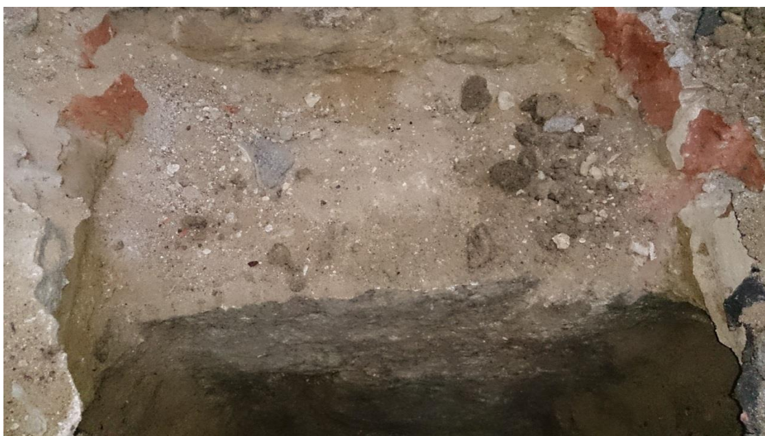
Fot. 4. Odkrywka fundamentu w miejscu projektowanej windy- odsadzka kamiennej ściany fundamentowej
