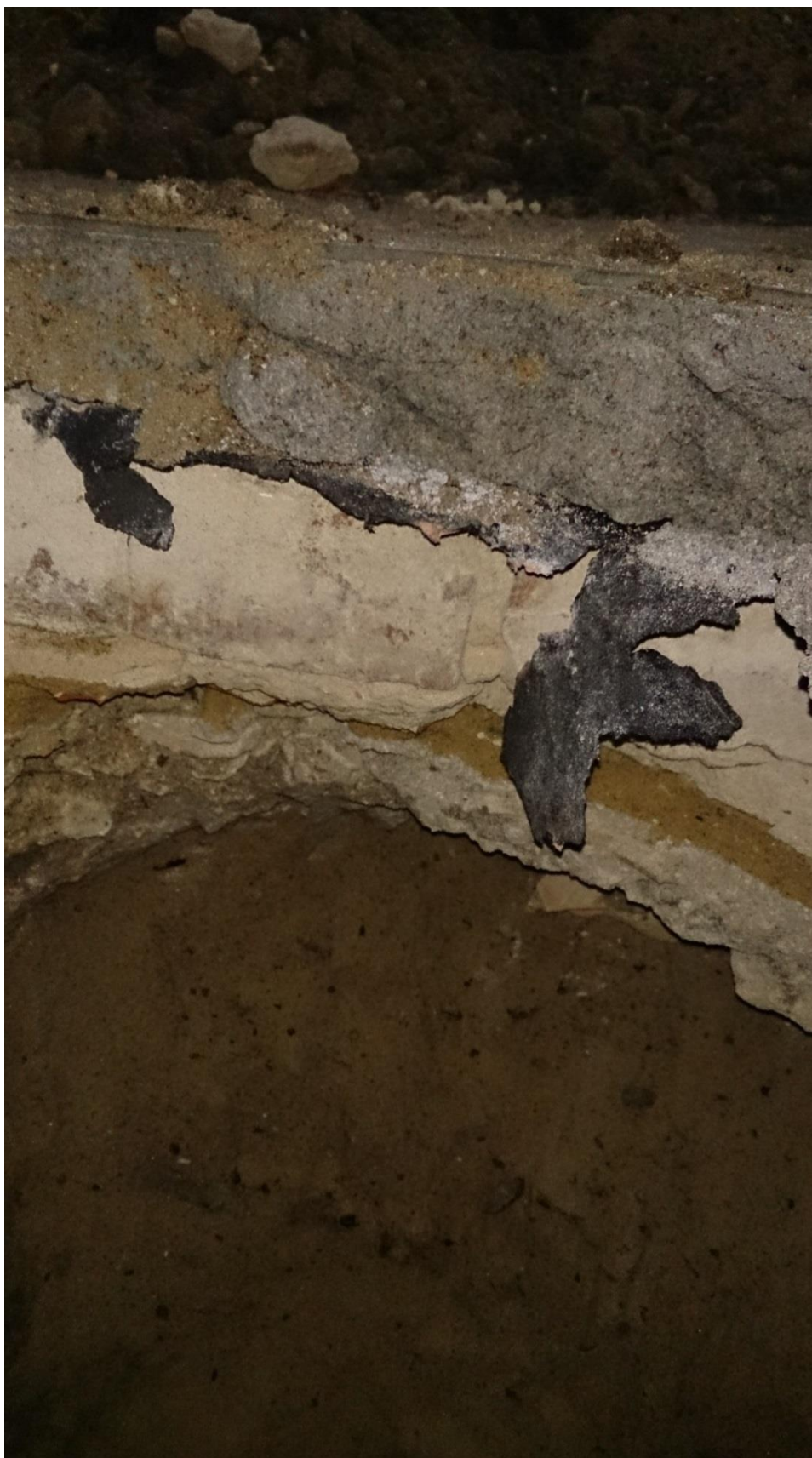
Fot. 6. Odkrywka warstw posadzki na gruncie w pomieszczeniu, do którego będzie przylegać projektowana winda
