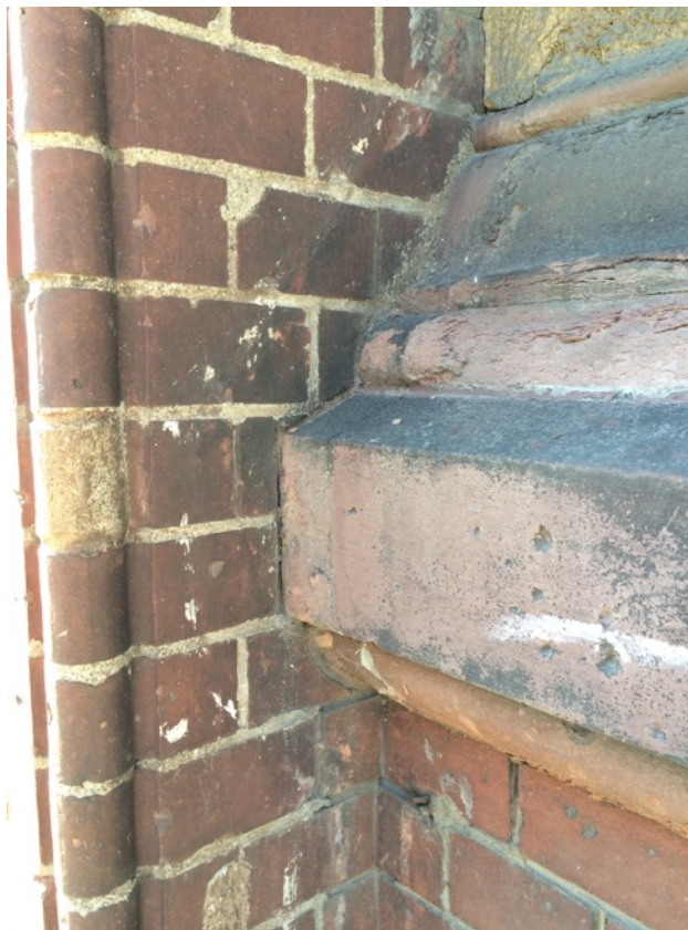
Fot. 8. Gzyms terakotowy części przyziemia - zniszczenia
