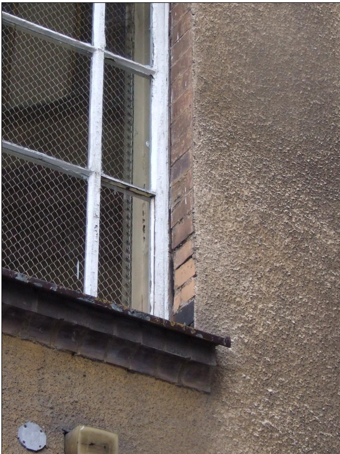
Fot. 24 Okno typu O2, uszkodzenia – elewacja zachodnia
