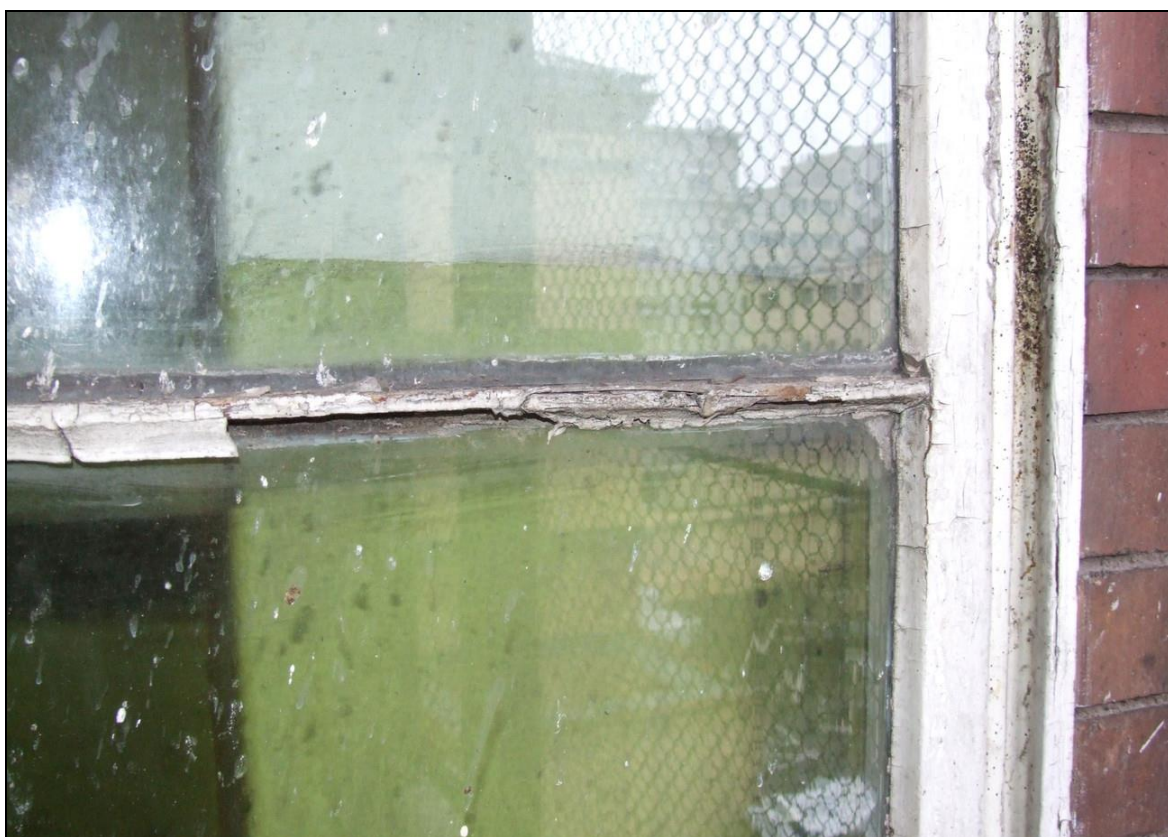
Fot. 40 Okno typu O7, uszkodzenia – boczna klatka schodowa
