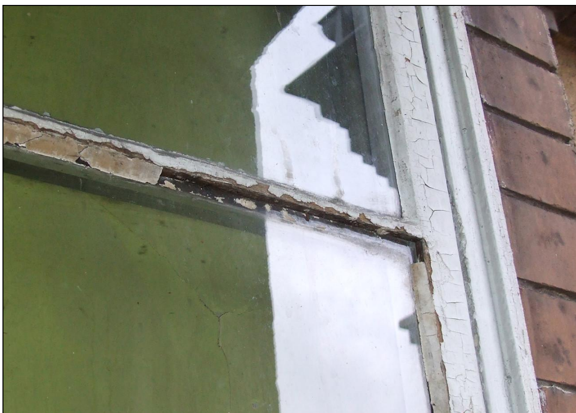
Fot. 50 Okna typu O8, uszkodzenia – boczna klatka schodowa
