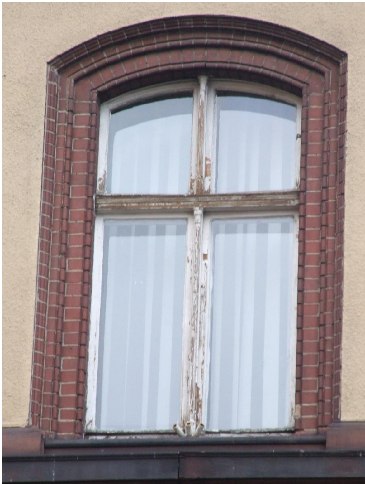
Fot. 8 Okno typu O1 (wariant ze szprosami), uszkodzenia – elewacja południowa
