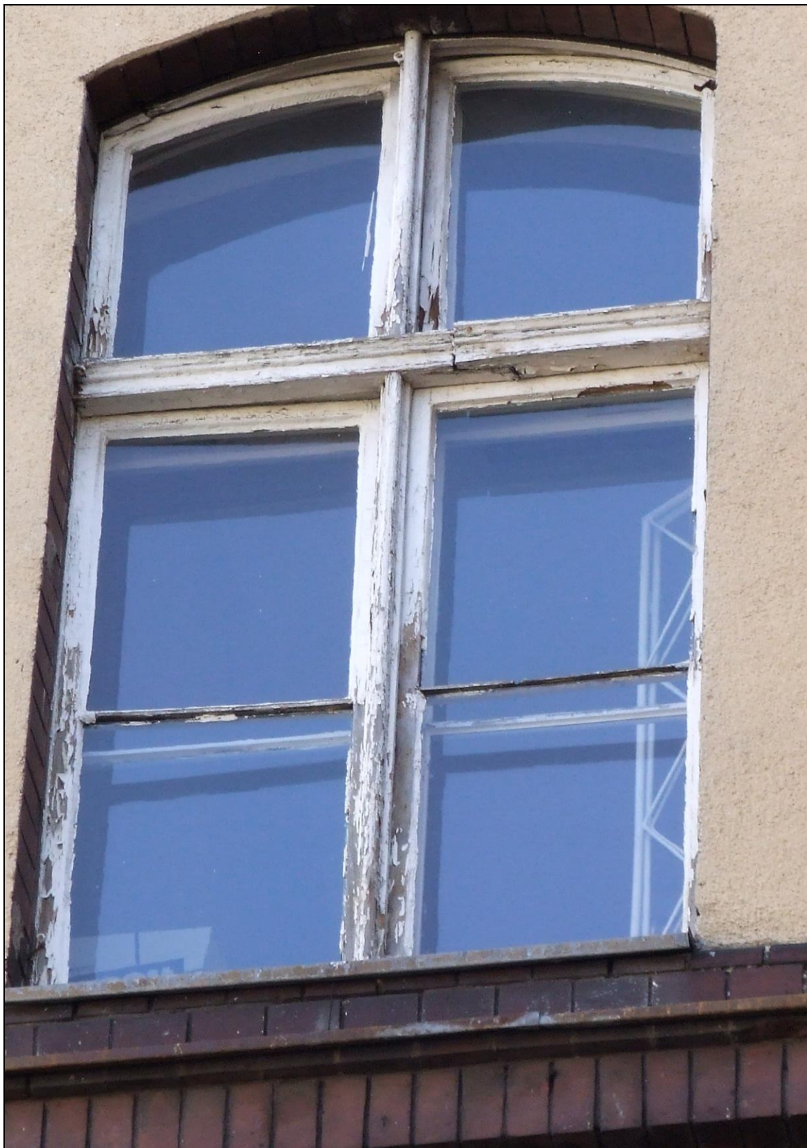
Fot. 7 Okno typu O1 (wariant ze szprosami), uszkodzenia – elewacja zachodnia
