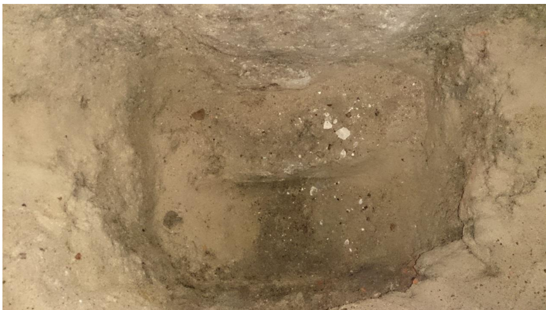
Fot. 5. Odkrywka fundamentu w miejscu projektowanej windy- odsadzka kamiennej ławy fundamentowej
