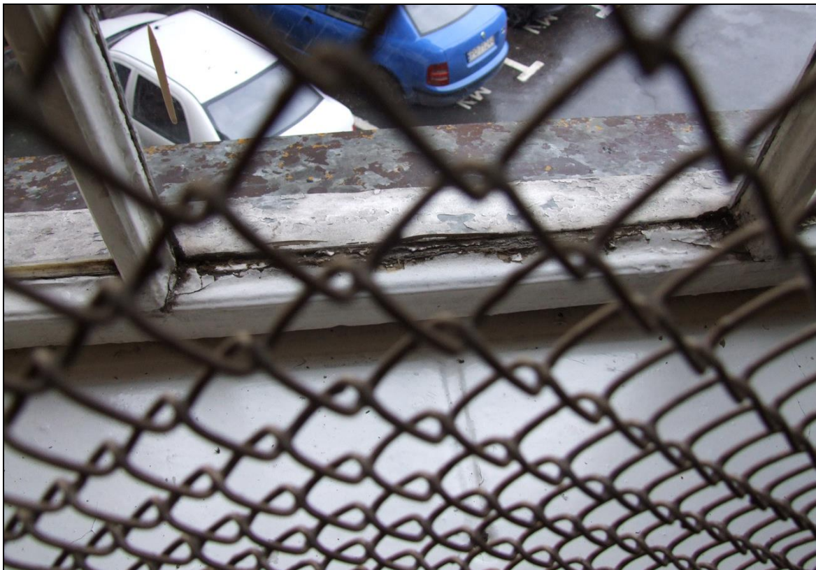
Fot. 28 Okno typu O2, uszkodzenia – elewacja zachodnia
