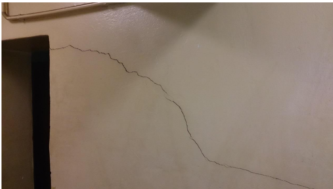
Fot. 9. Spękanie ściany piwnicy spowodowane nierównomiernym osiadaniem
