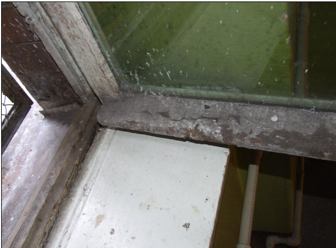
Fot. 41 Okno typu O7, uszkodzenia – boczna klatka schodowa
