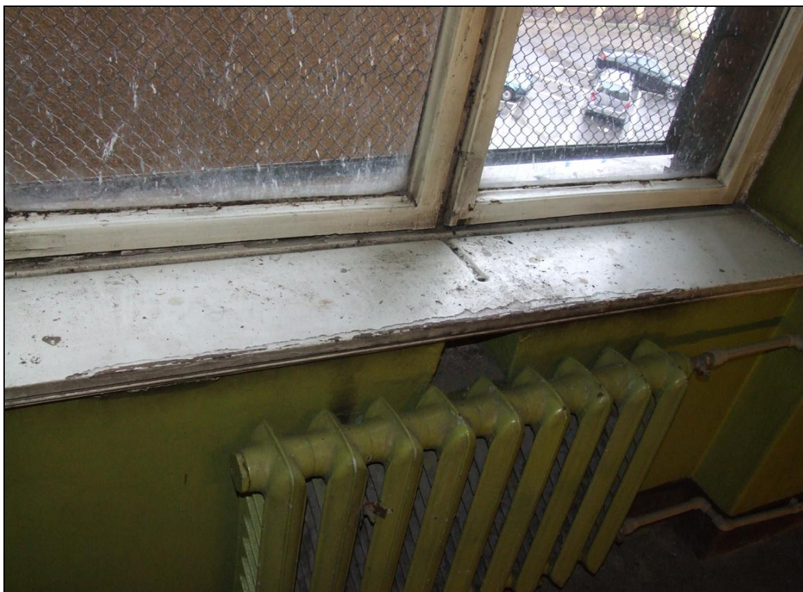
Fot. 39 Okno typu O7, uszkodzenia – boczna klatka schodowa
