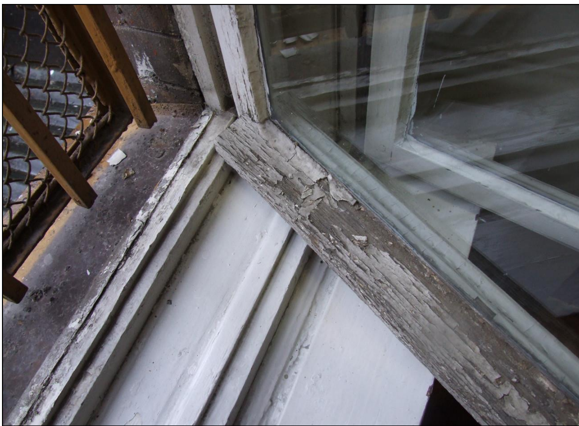
Fot. 10 Okno typu O1 (wariant ze szprosami), uszkodzenia – elewacja zachodnia
