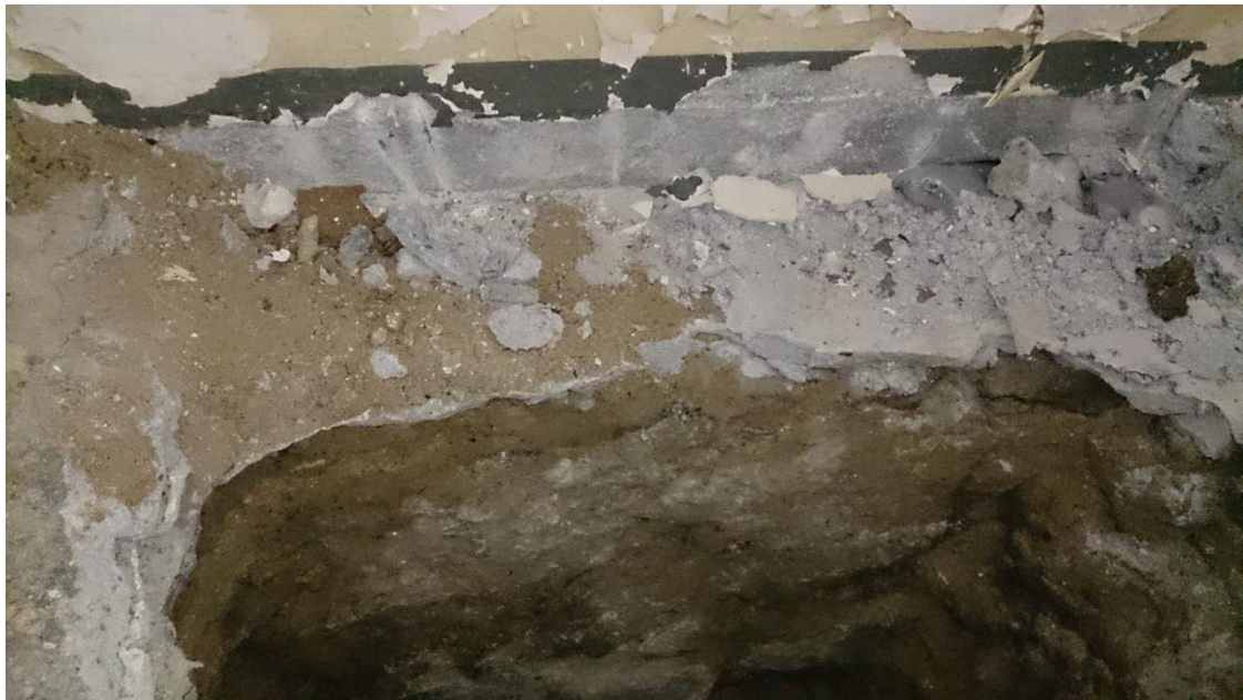
Fot. 7. Odkrywka nr 04 fundamentu w miejscu, gdzie projektuje sąsiadujący budynek z salą odpraw
