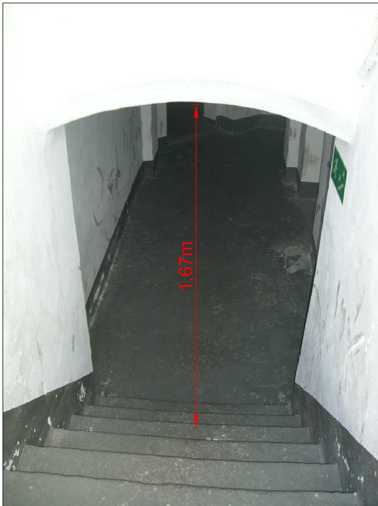
Fot. 3 Zaniżona wysokość wyjścia schodami do drzwi DZ1
