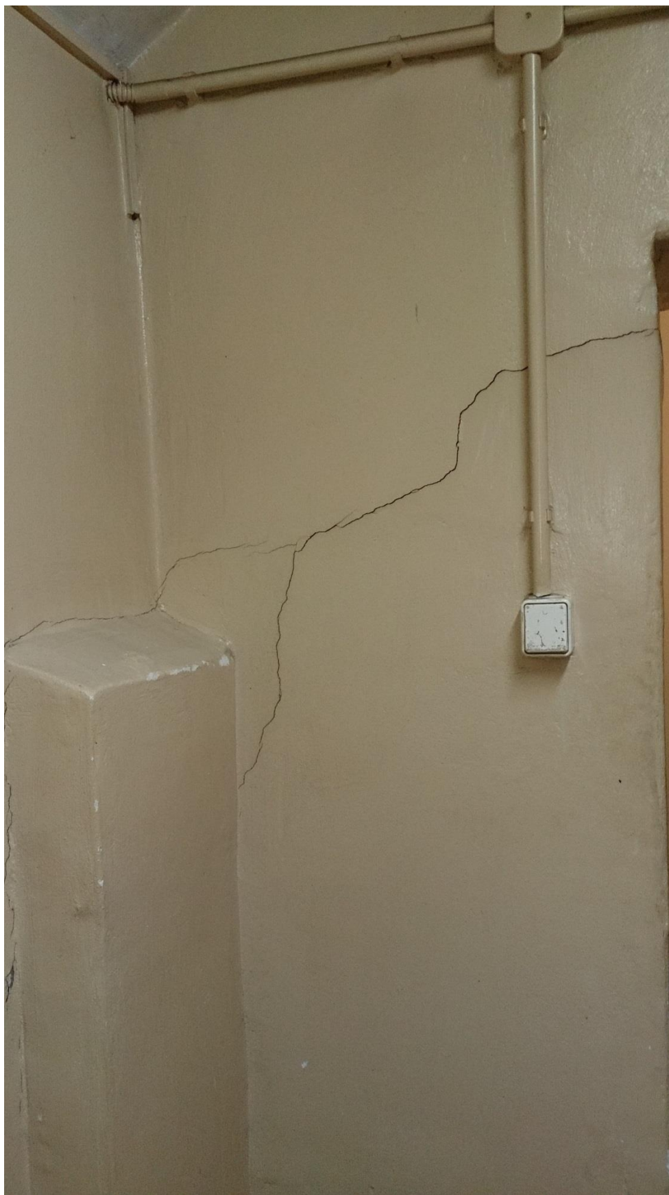
Fot. 11. Spękanie ściany piwnicy spowodowane nierównomiernym osiadaniem
