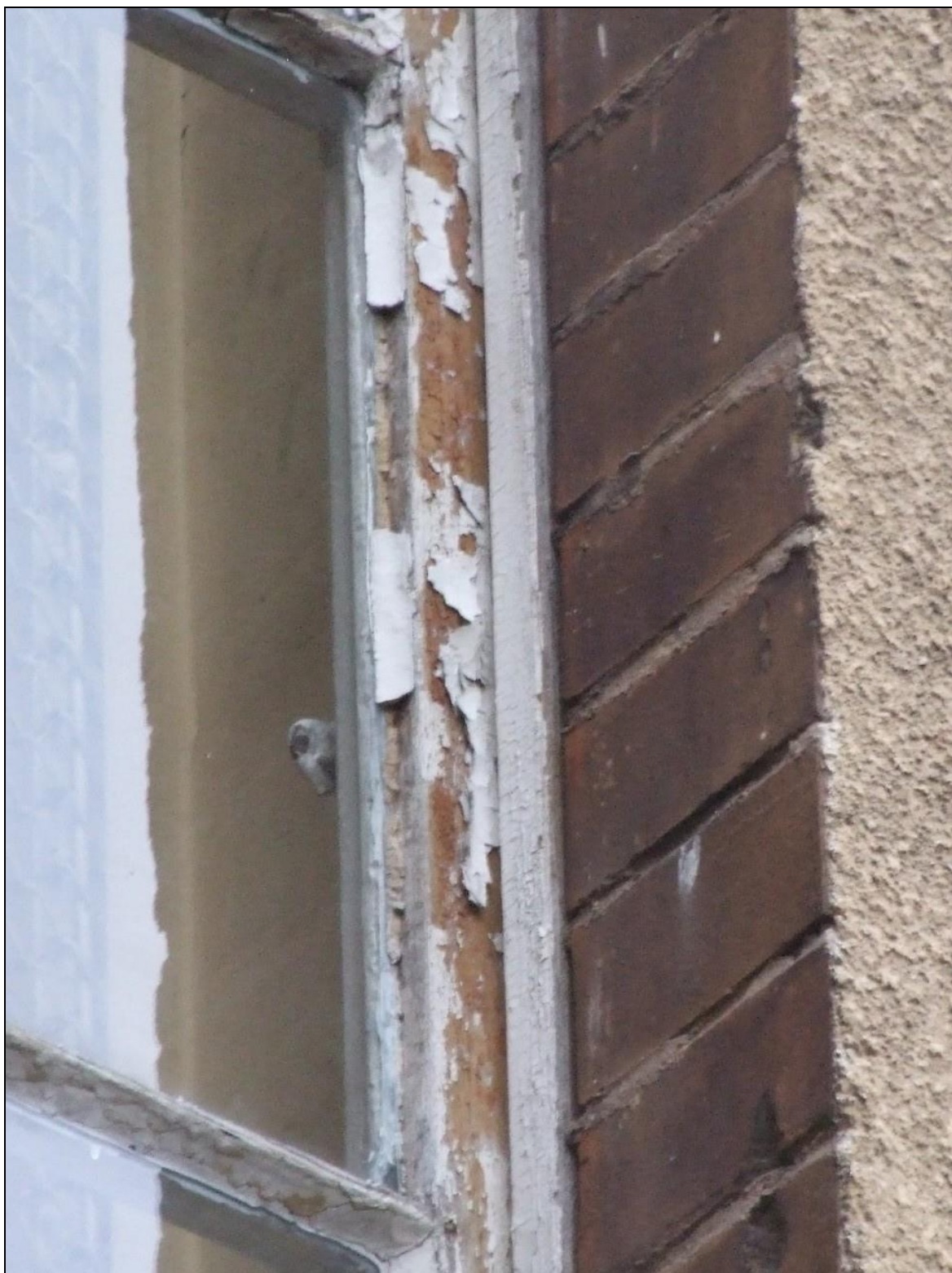
Fot. 25 Okno typu O2, uszkodzenia – elewacja zachodnia
