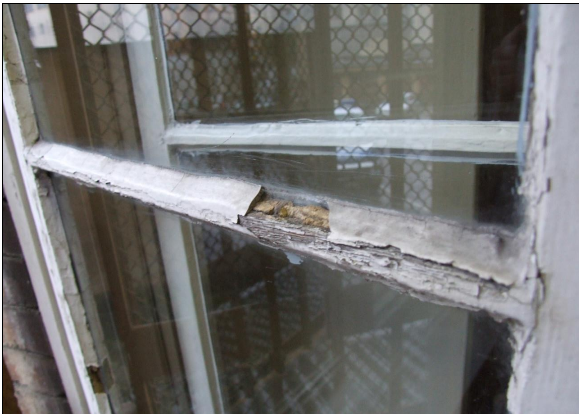
Fot. 9 Okno typu O1 (wariant ze szprosami), uszkodzenia – elewacja zachodnia
