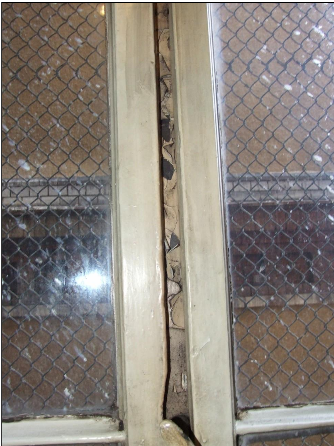
Fot. 38 Okno typu O7, uszkodzenia – boczna klatka schodowa
