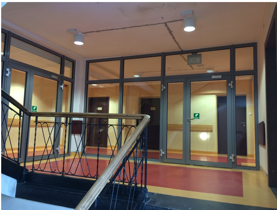
Posadzka piętra III – podest poddany remontowi w trakcie wcześniejszego remontu; remontowi podlegają ściany, sufit oraz odboje ścienne, poręcze schodów wraz z okładziną schodową
