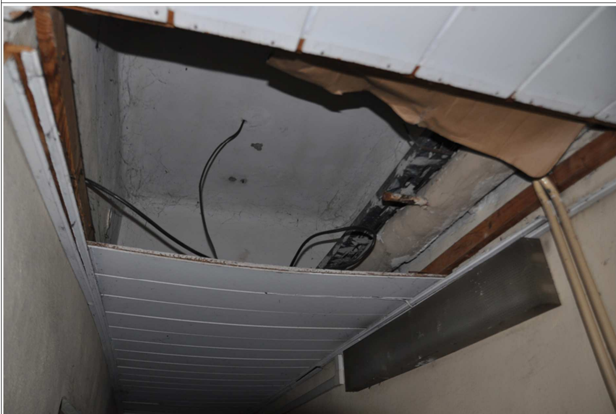
Fot. 13 Budynek przeznaczony do rozbiórki – sufit stalowy podwieszany w części podpiwniczonej
