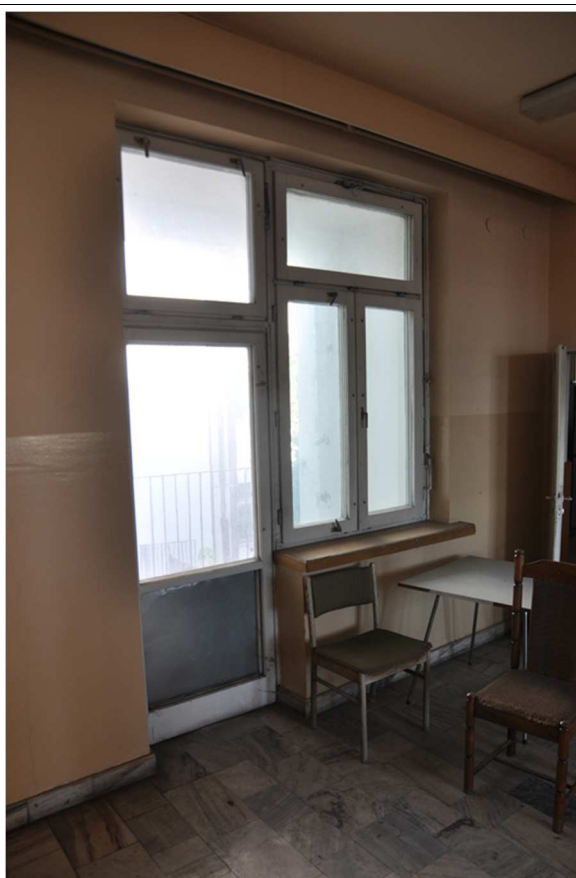
Fot. 11 Budynek przeznaczony do rozbiórki – stolarka okienna drewniana
