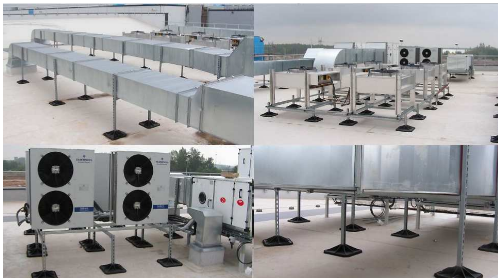
Rysunek 2. Widok systemu oparcia kanałów, instalacji lub innych urządzeń
