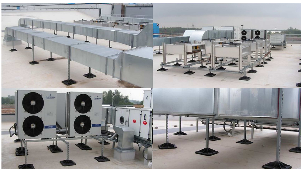
Rysunek 2. Widok systemu oparcia kanałów, instalacji lub innych urządzeń
